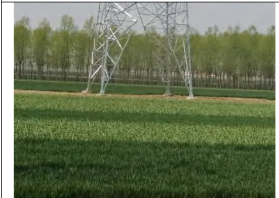
2024年3月塔基区铁塔组立
