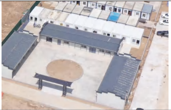
2024年3月施工生产生活区
