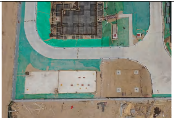
2024年4月站区防尘网苫盖
