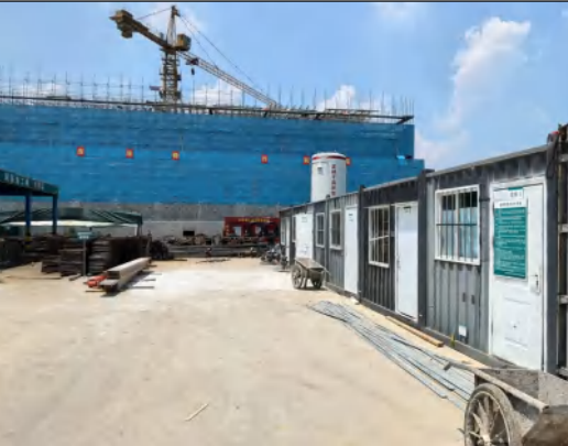
2024年6月施工生产生活区
