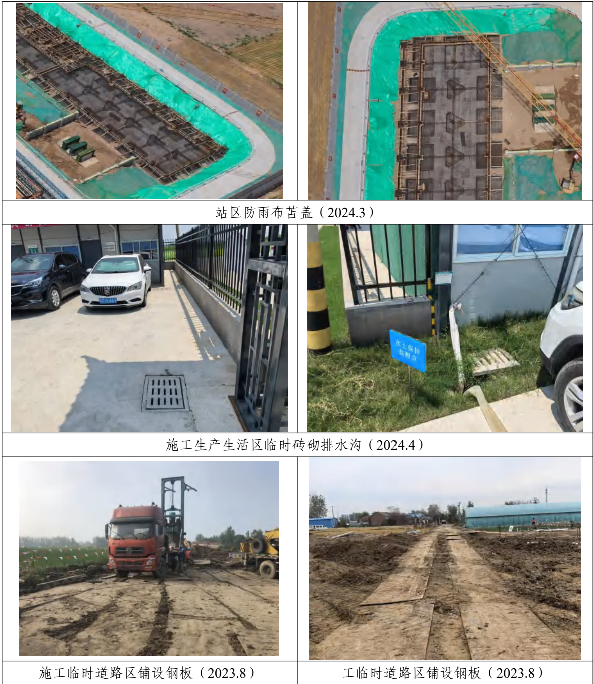
图 4-3 水土保持临时措施实施情况
