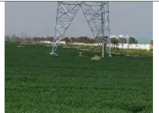
2024年3月塔基区铁塔组立
