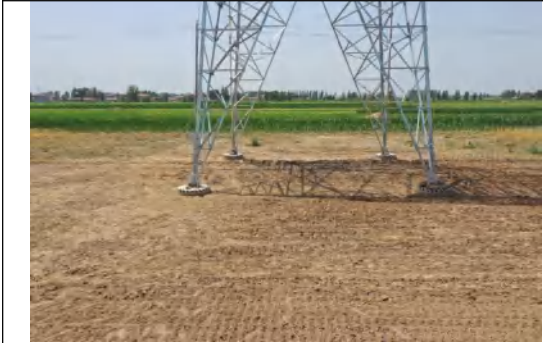
2024年6月塔基区土地整治
