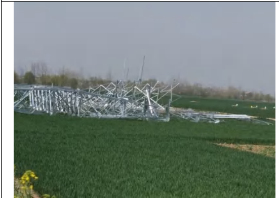
2024年3月塔基区铁塔组立
