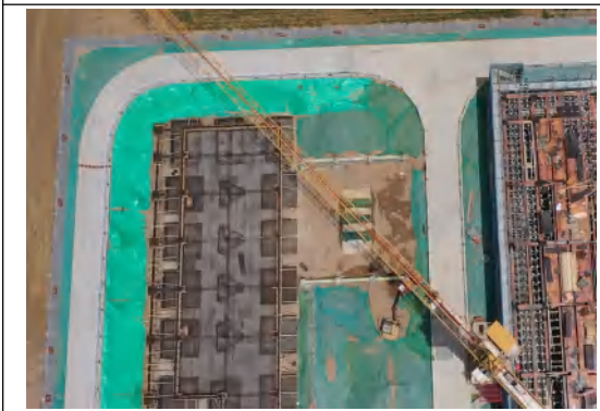
2024年4月站区防尘网苫盖
