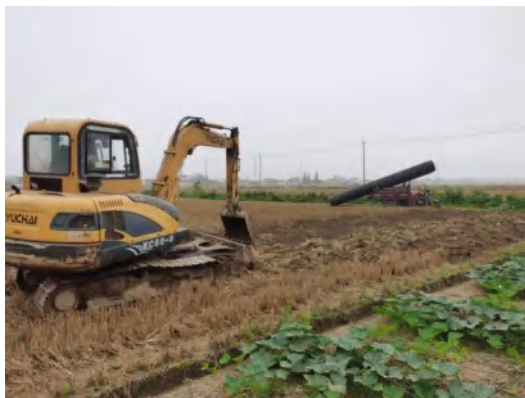
塔基区表土剥离（2023.8）
