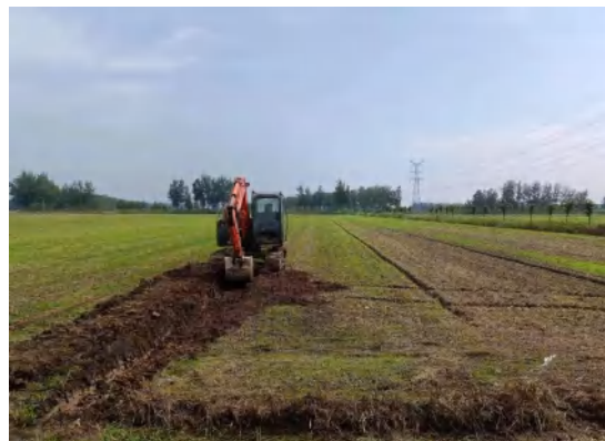
塔基区表土剥离（2023.11）
