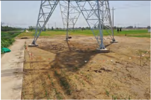
2024年6月塔基区土地整治
