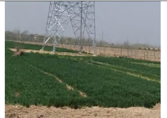
2024年3月塔基区铁塔组立
