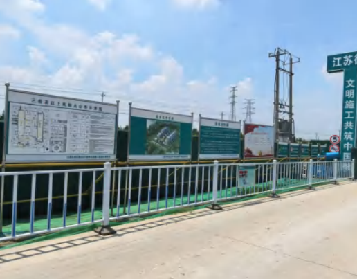
2024年6月施工生产生活区
