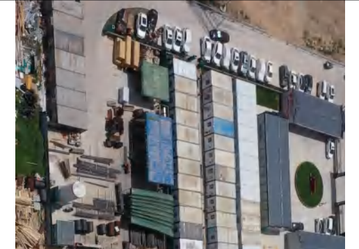
2024年6月施工生产生活区
