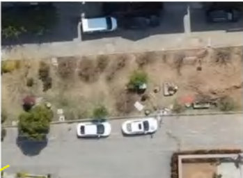
电缆施工区撒播狗牙根草籽和综合绿化恢复
