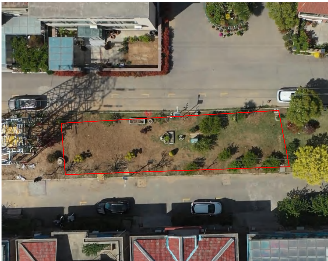
电缆施工区完工后 2025.3
