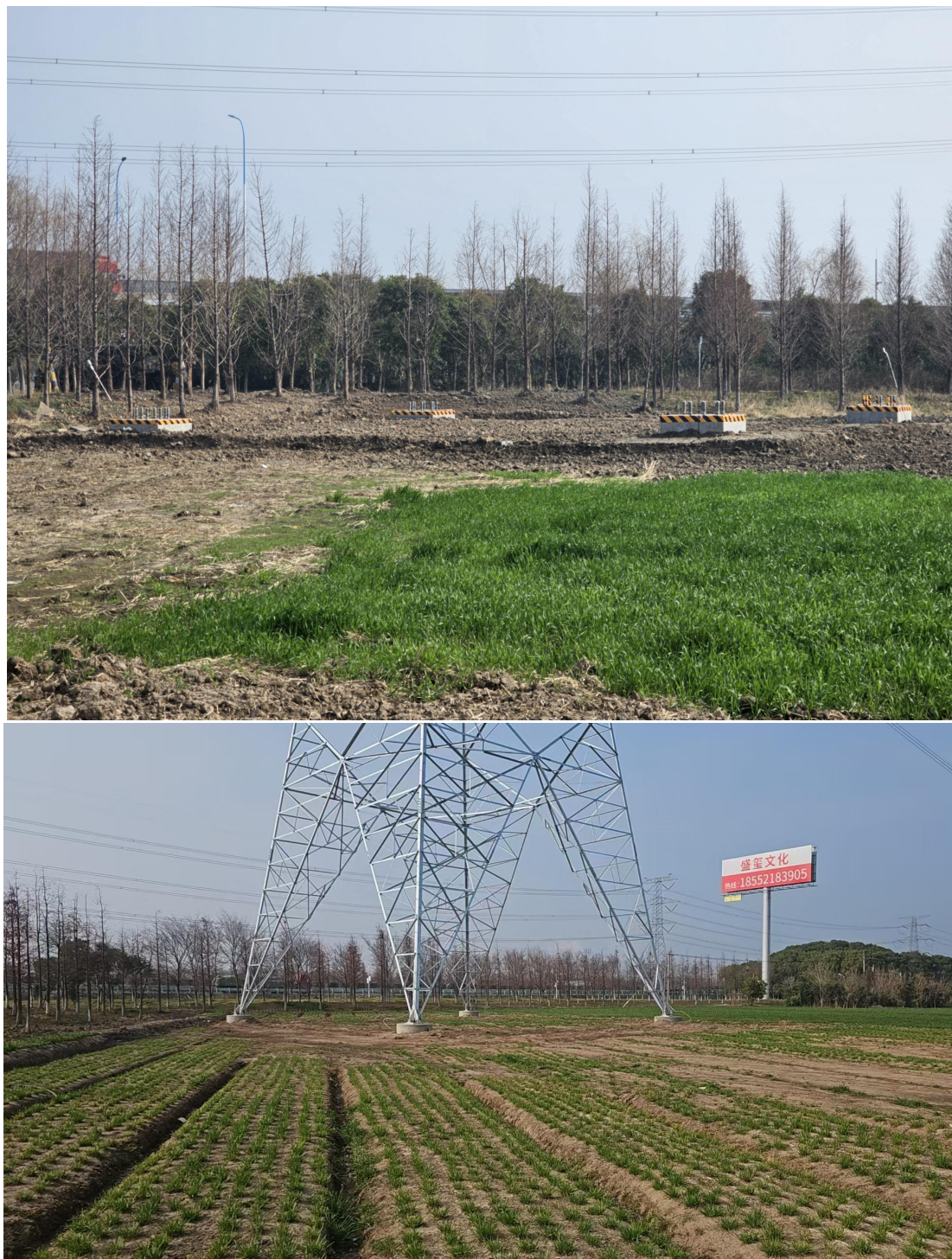
塔基及塔基施工区图-3 月
