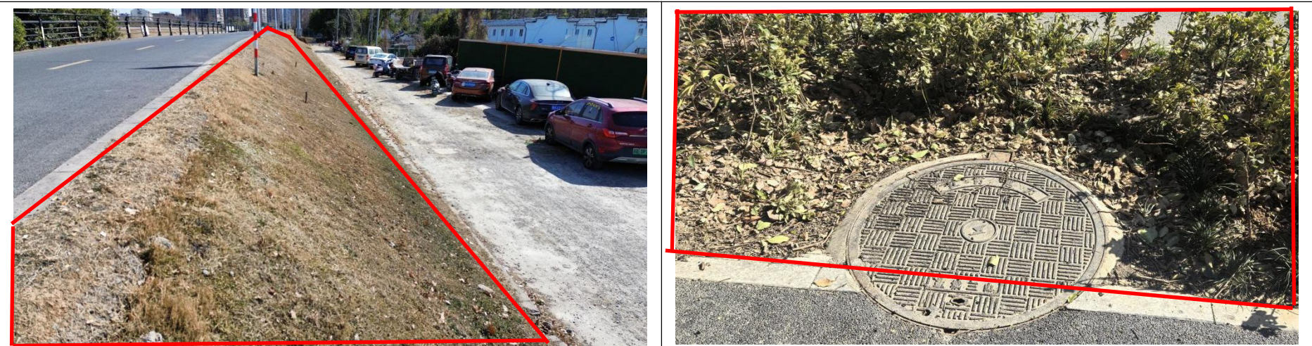
电缆施工区植被建设工程
