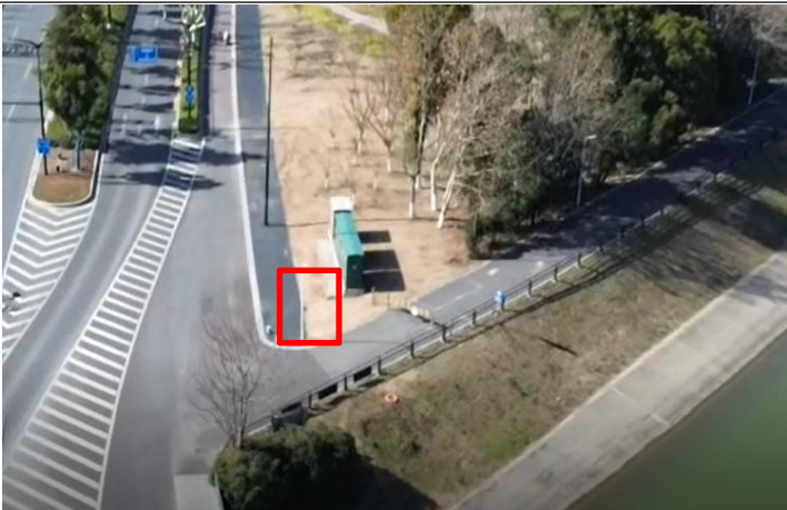
施工临时道路区植被建设工程
