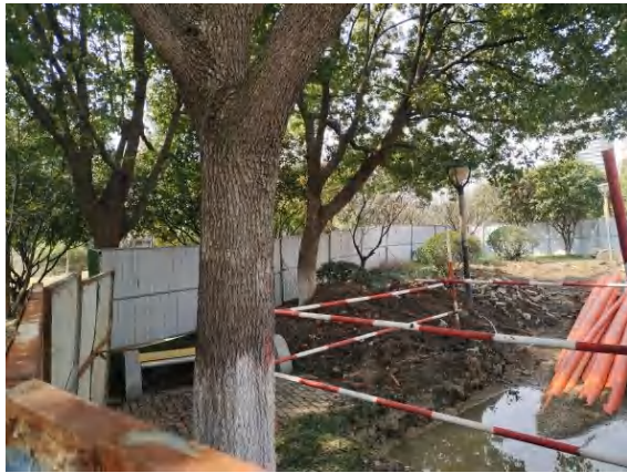
电缆施工区 泥浆沉淀池（2024年3月）
