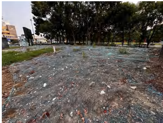
电缆施工区 防尘网苫盖（2024年7月）
