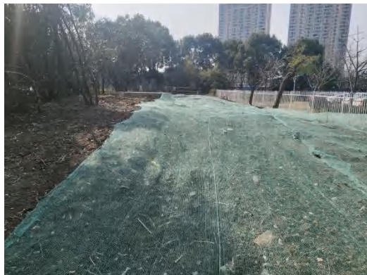
电缆施工区 防尘网苫盖（2024年3月）
