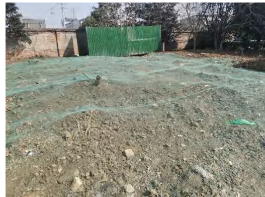
电缆施工区 防尘网苫盖（2024年3月）
