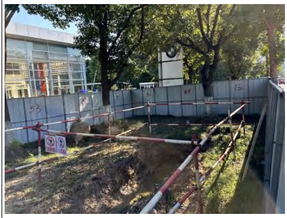
电缆施工区 泥浆沉淀池（2024年7月）
