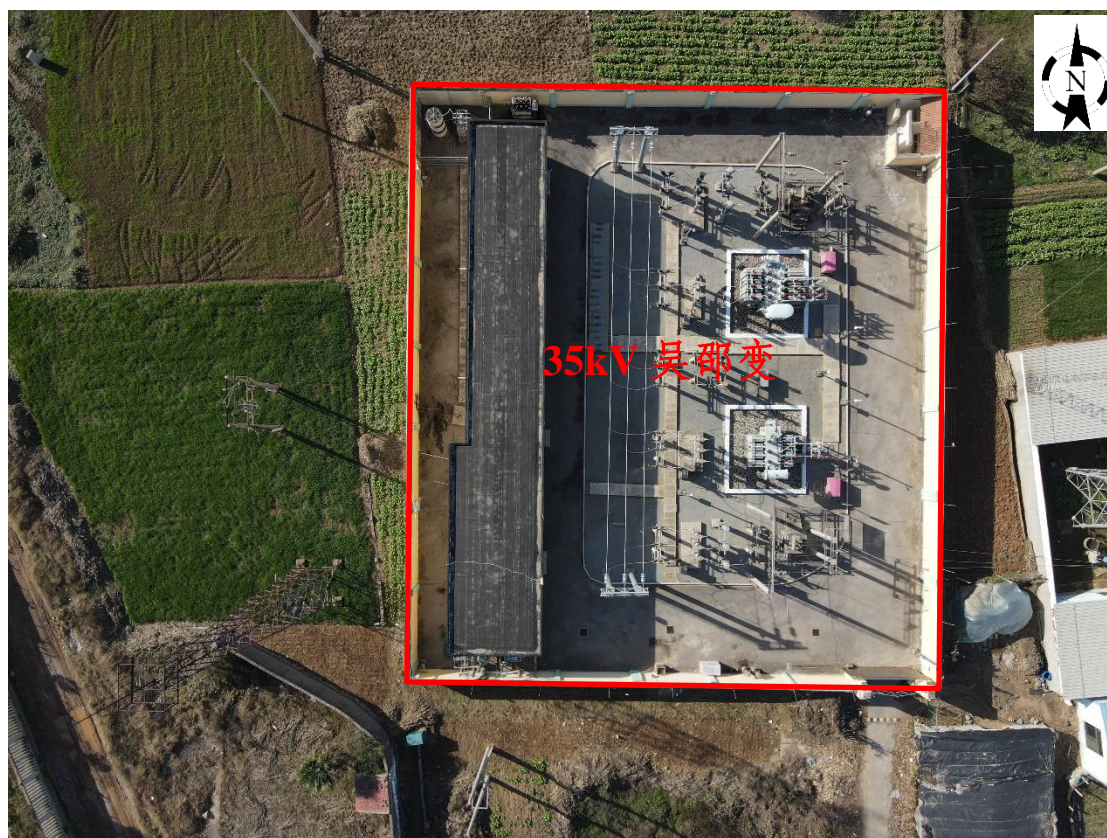
图 1.1-2 吴邵 35 千伏变电站站址现状
