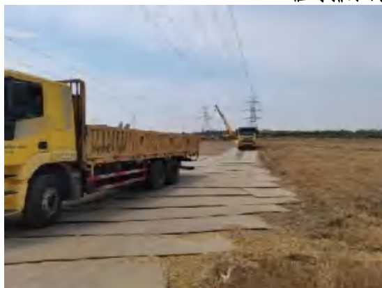
施工道路区 铺设钢板（2023.06）
