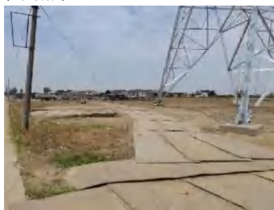
施工道路区 铺设钢板（2023.06）
