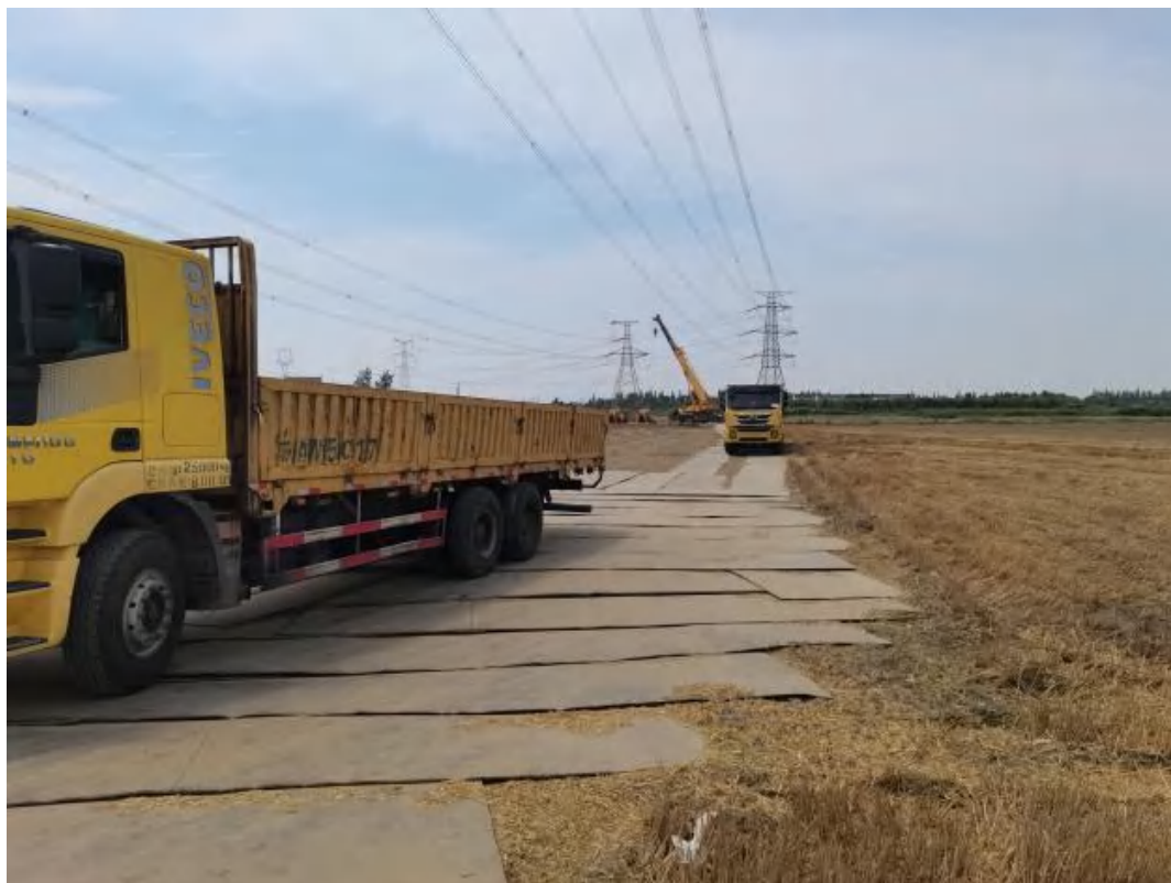
施工道路区 铺设钢板 (2023.06)
