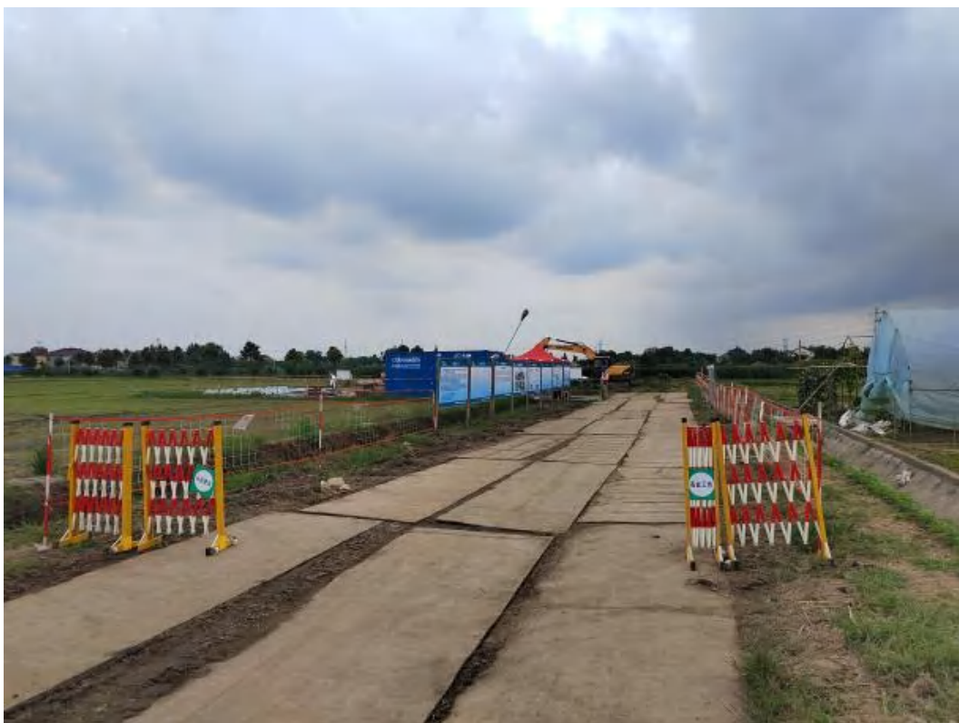
施工道路区 铺设钢板（2024.08）
