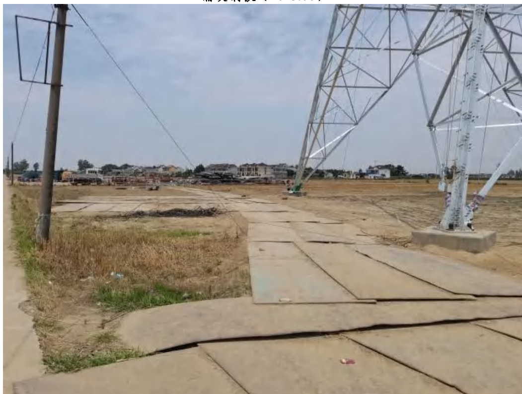
施工道路区 铺设钢板 (2023.06)
