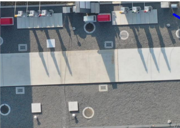
变电站区排水管网措施
