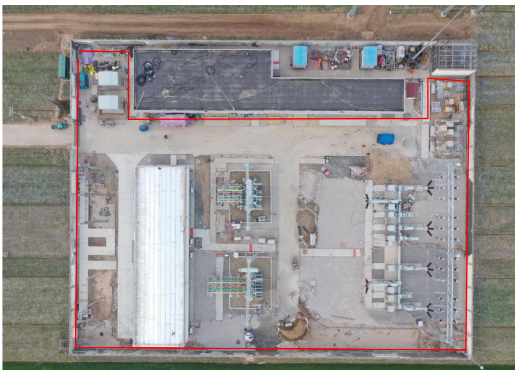
变电站改造区完工后 2024.11
