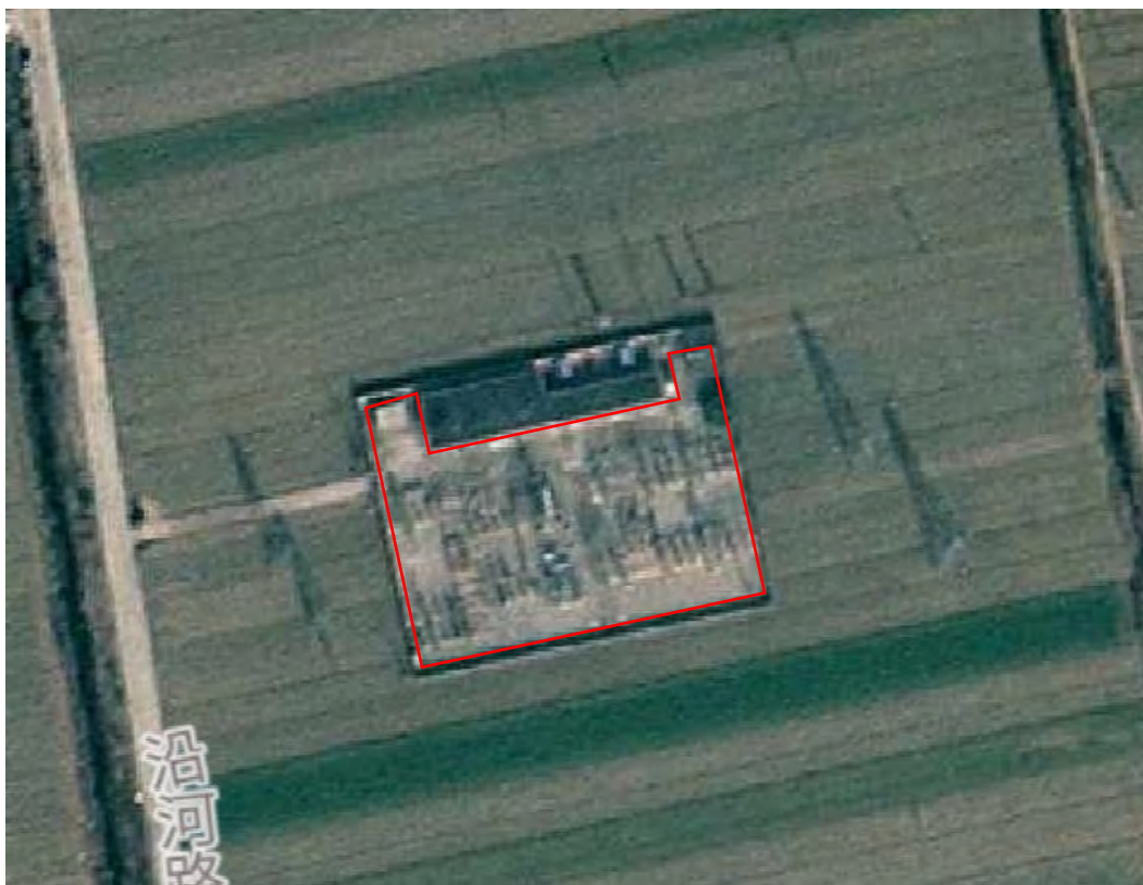
变电站改造区施工前期 2024.1
