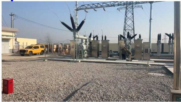
变电站区碎石压盖措施
