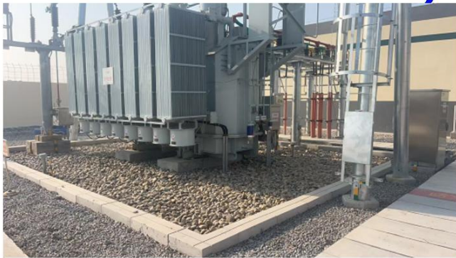
变电站区碎石压盖措施
