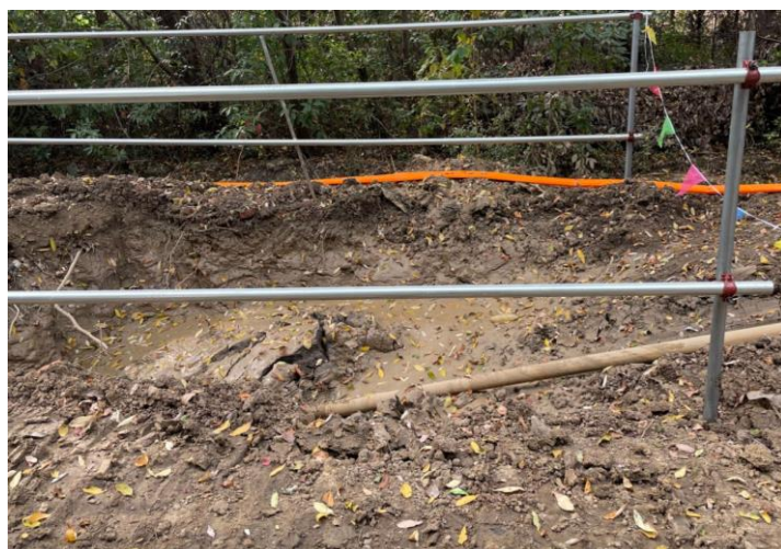
电缆施工区施工过程中 2023.11
