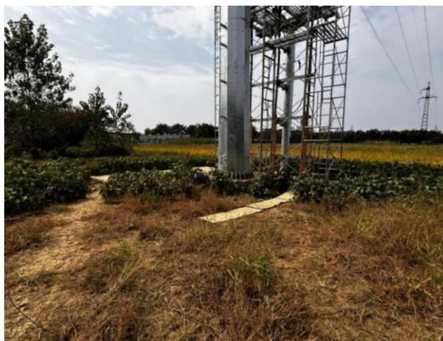
塔基区施工过程中 2024.10
