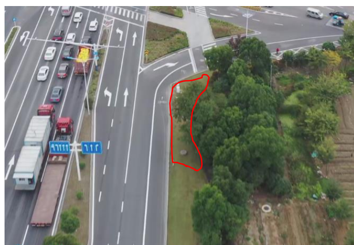
电缆施工区完工后 2024.12
