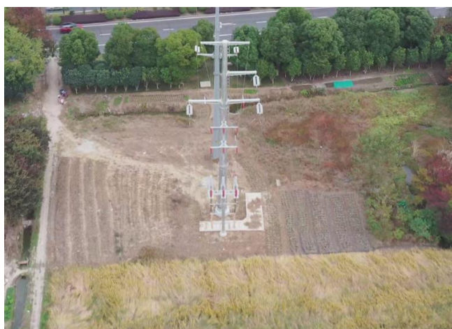
塔基区完工后 2024.12
