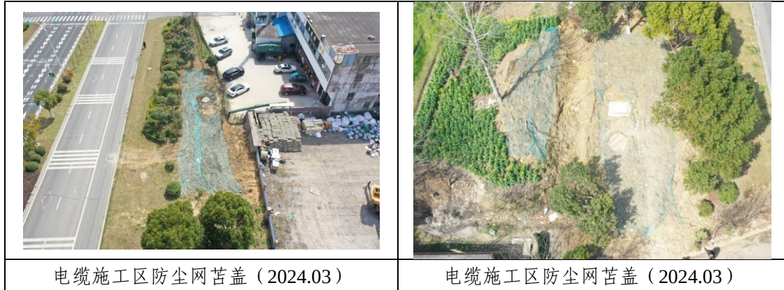
图 4-3 水土保持临时措施实施情况
