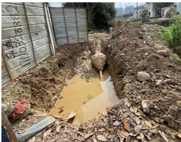
电缆施工区施工过程中 2023.11
