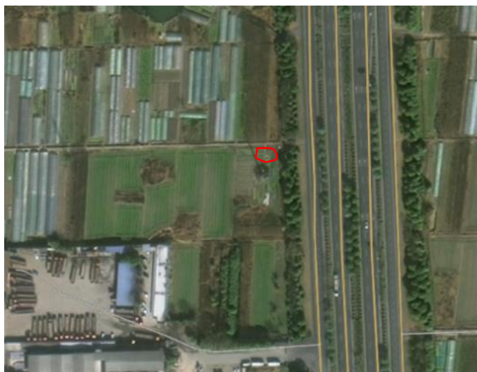
塔基区施工前期 2023.04
