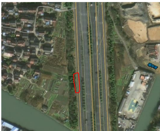
电缆施工区施工前期 2023.04
