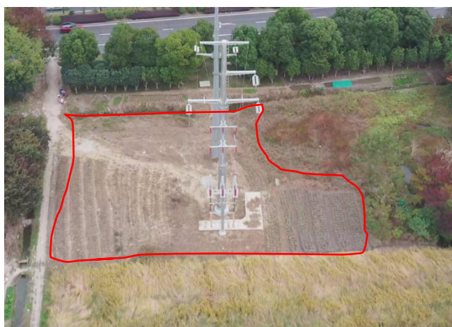
塔基区完工后 2024.12
