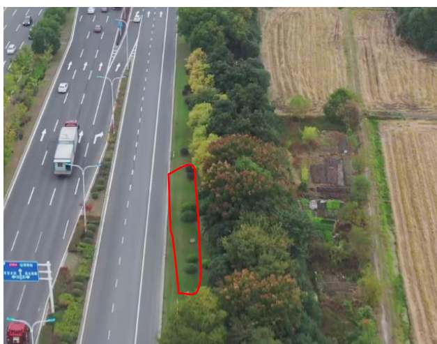
电缆施工区完工后 2024.12
