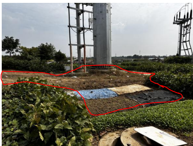
塔基区施工过程中 2024.09
