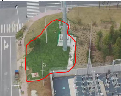
电缆施工区撒播草籽 (2024年12月04日)
