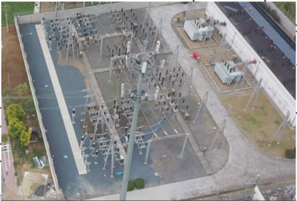
间隔扩建区碎石压盖 (2024年12月04日)
