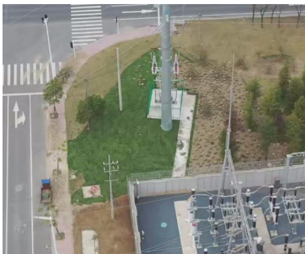
电缆施工区完工后 2024.12
