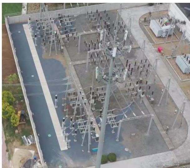
间隔扩建区完工后 2024.12
