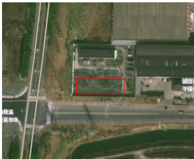
间隔扩建区施工前期 2023.04
