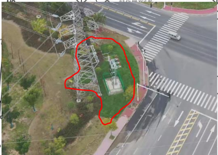
电缆施工区撒播草籽 (2024年12月04日)
