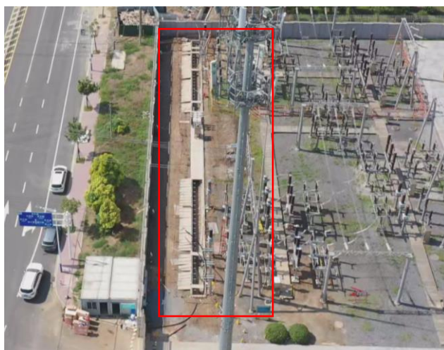
间隔扩建区施工过程中 2024.09
