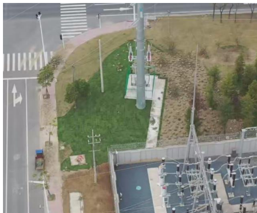
电缆施工区撒播草籽
