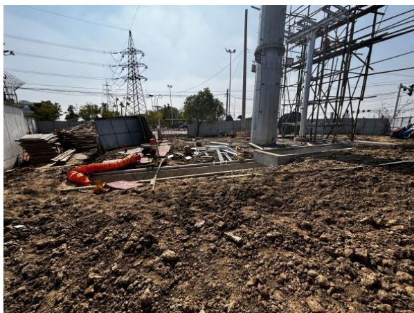
电缆施工区施工过程中 2024.09
