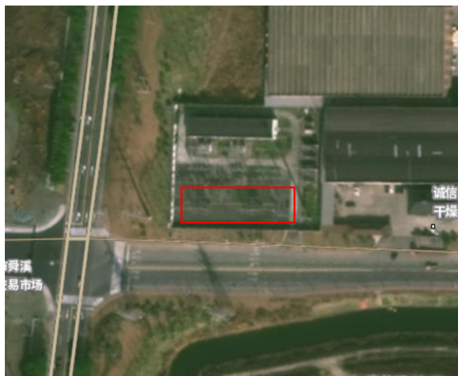
间隔扩建区施工前期 2023.04
