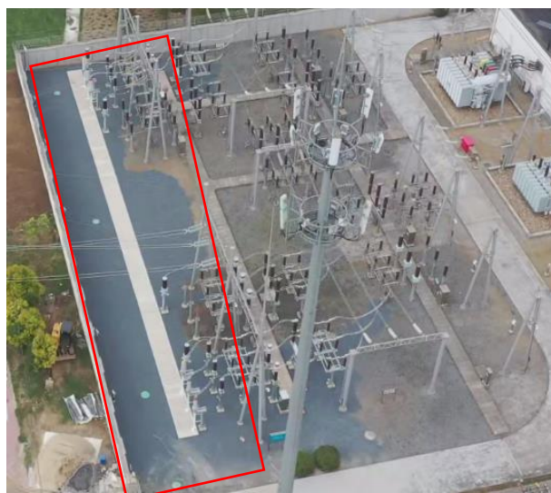
间隔扩建区完工后 2024.12
