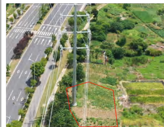
塔基区 (B10) 复耕 撒播草籽 2024.08
