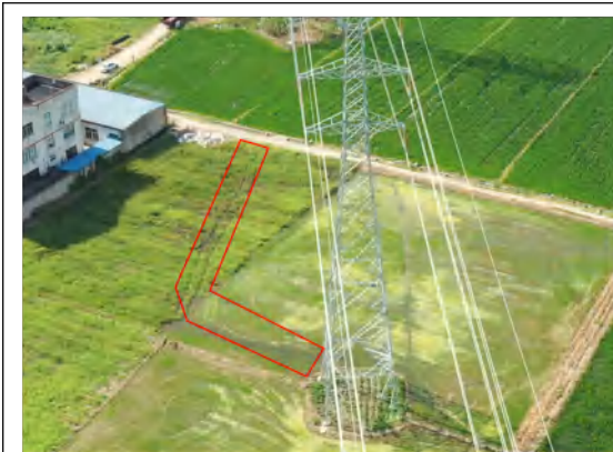
施工临时道路区 复耕 撒播草籽 2024.08
