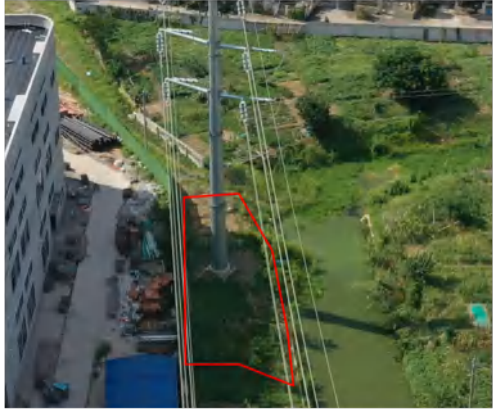
塔基区 (A8) 复耕 撒播草籽 2024.08
