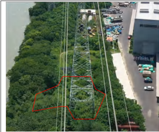
塔基区 (A34) 撒播草籽 2024.08
