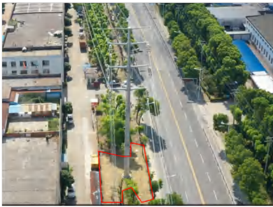
塔基区 (A19) 撒播草籽 2024.08
