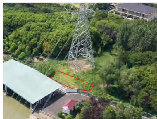
牵张场及跨越场区 撒播草籽 2024.08
