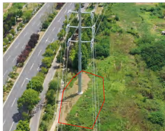
塔基区 (B11) 撒播草籽 2024.08
