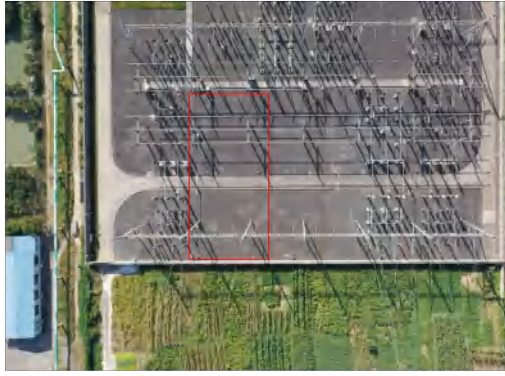
间隔扩建区（依坝变） 施工前（2021.07）
