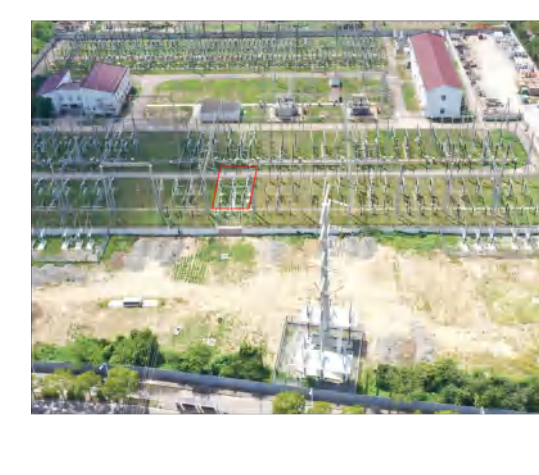
间隔扩建区 (东亭变) 撒播草籽 2024.08
