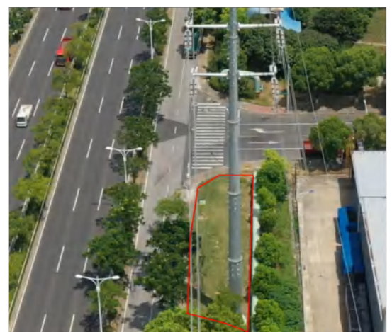
塔基区 (B19) 撒播草籽 2024.08
