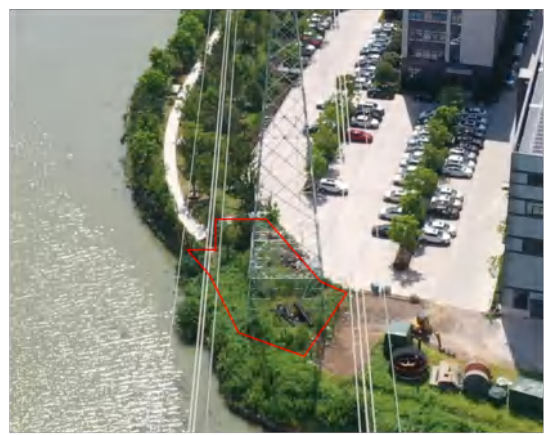
塔基区 (A33) 撒播草籽 2024.08
