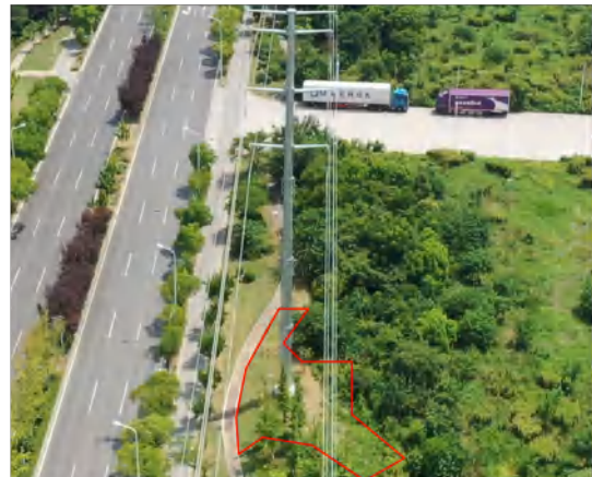
塔基区 (B13) 撒播草籽 2024.08
