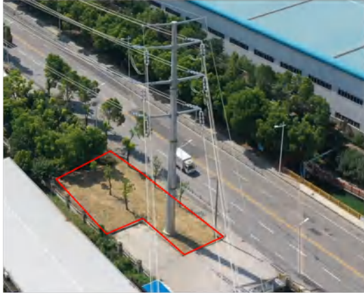
塔基区 (A23) 撒播草籽 2024.08
