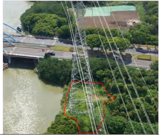
塔基区 (A35) 撒播草籽 2024.08
