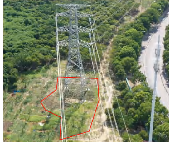
塔基区 (A28) 复耕 撒播草籽 2024.08
