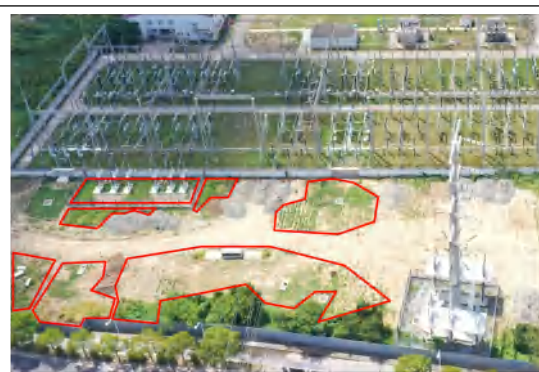
电缆施工区 复耕 撒播草籽 2024.07
