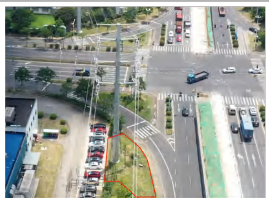
塔基区 (B22) 撒播草籽 2024.08
