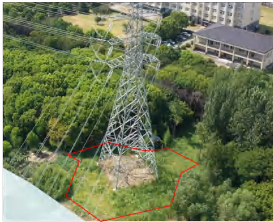
塔基区 (A36) 撒播草籽 2024.08
