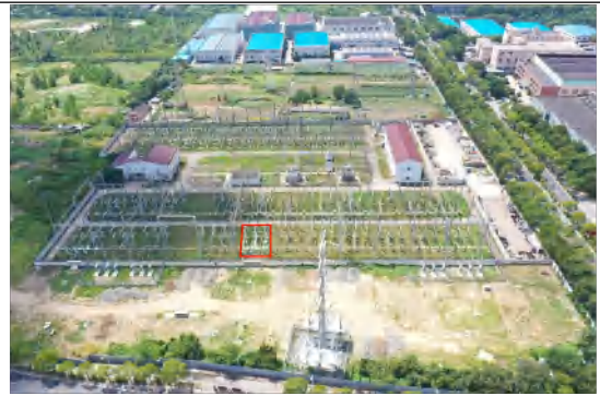
间隔扩建区（东亭变） 施工后（2024.08）
