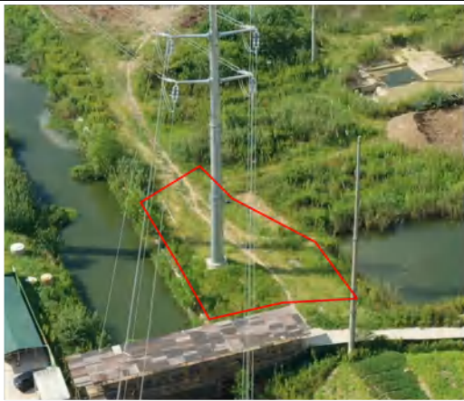
塔基区 (A13) 撒播草籽 2024.08
