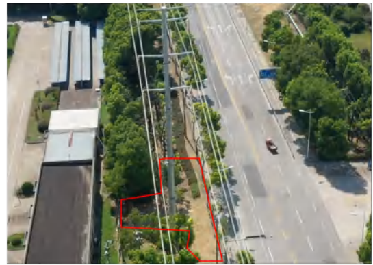
塔基区 (A22) 撒播草籽 2024.08
