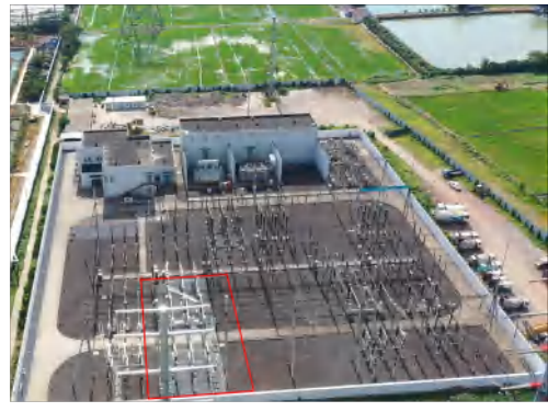
间隔扩建区（依坝变） 施工后（2024.08）
