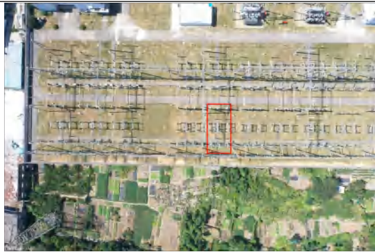
间隔扩建区（东亭变） 施工前（2021.07）
