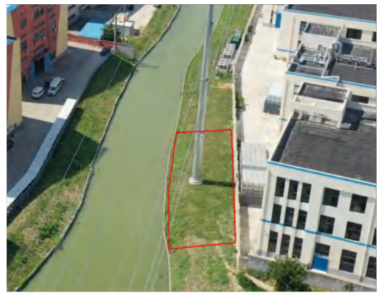
塔基区 (A26) 撒播草籽 2024.08
