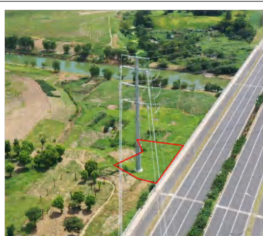
塔基区 (B9) 撒播草籽 2024.08
