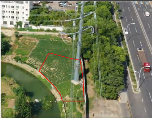
塔基区 (A10) 复耕 2024.08
