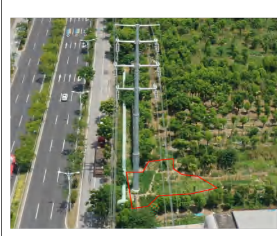
塔基区 (B18) 撒播草籽 2024.08
