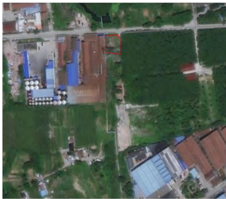
塔基区（A4） 施工前（2020.03）
