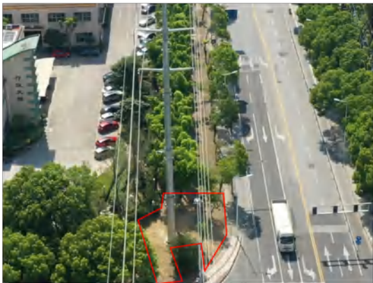
塔基区 (A21) 撒播草籽 2024.08
