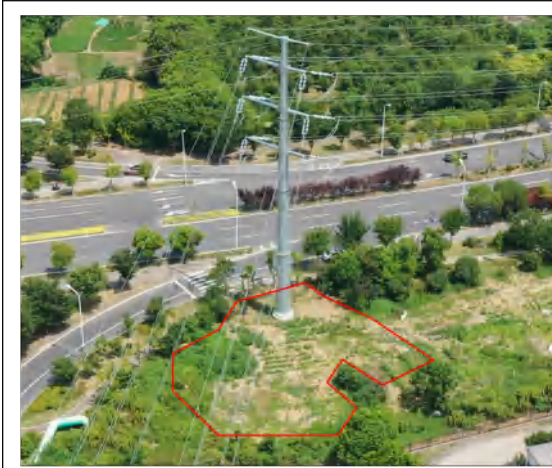
塔基区 (B15) 撒播草籽 2024.08
