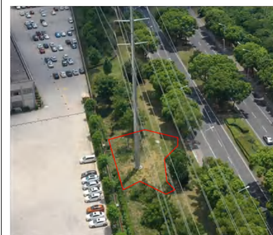
塔基区 (B25) 撒播草籽 2024.08
