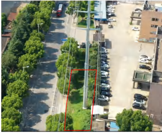
塔基区 (A17) 撒播草籽 2024.08
