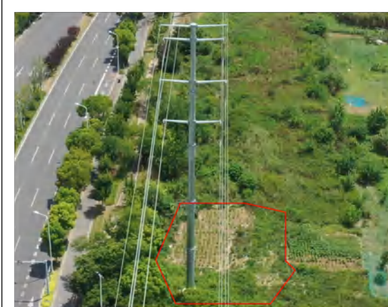
塔基区 (B12) 复耕 撒播草籽 2024.08
