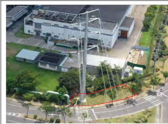
塔基区 (B21) 撒播草籽 2024.08
