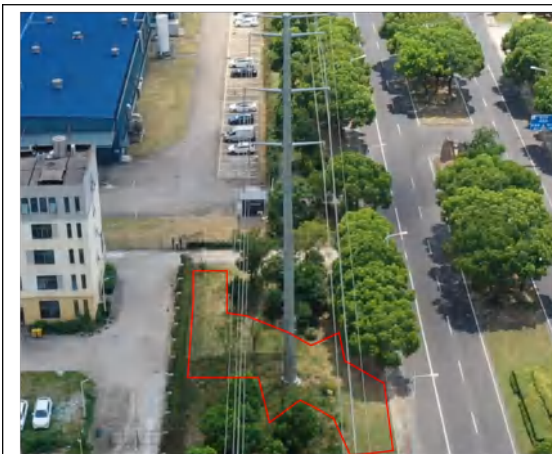
塔基区 (B23) 撒播草籽 2024.08
