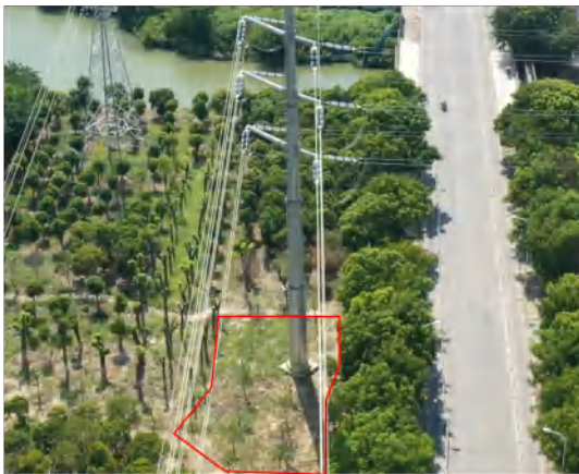
塔基区 (A27) 撒播草籽 2024.08
