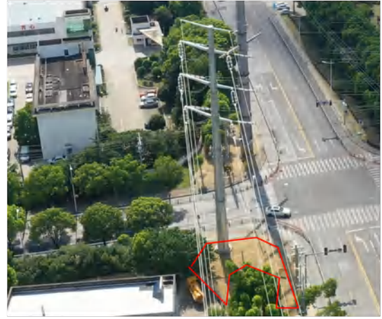
塔基区 (A18) 撒播草籽 2024.08
