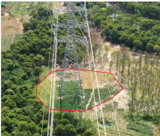
塔基区 (A29) 复耕 撒播草籽 2024.08
