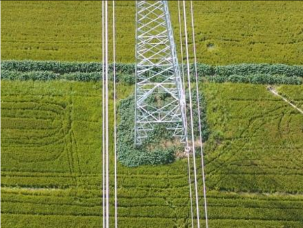
扬州秦邮~澄子 110kV 线路改造工程塔基生态恢复示例
