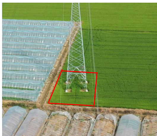
塔基区 T16 复耕 (2024 年 8 月)
