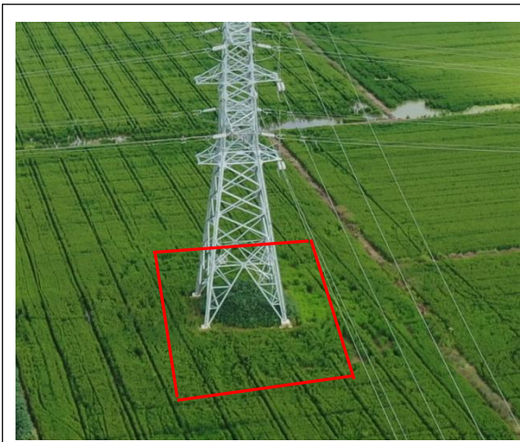
塔基区 T21 复耕 (2024 年 8 月)
