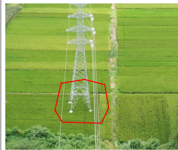
塔基区 T11 复耕 (2024 年 8 月)
