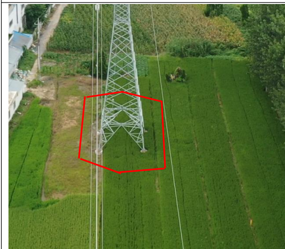
塔基区 T25 复耕 (2024 年 8 月)
