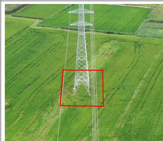
塔基区 T13 复耕 (2024 年 8 月)
