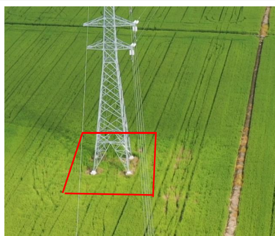
塔基区 T17 复耕 (2024 年 8 月)
