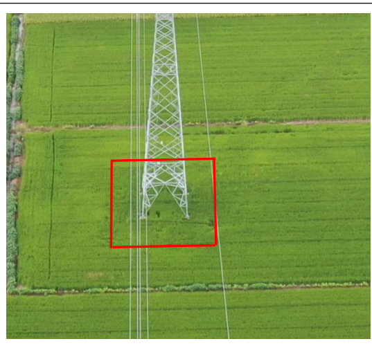
塔基区 T28 复耕 (2024 年 8 月)
