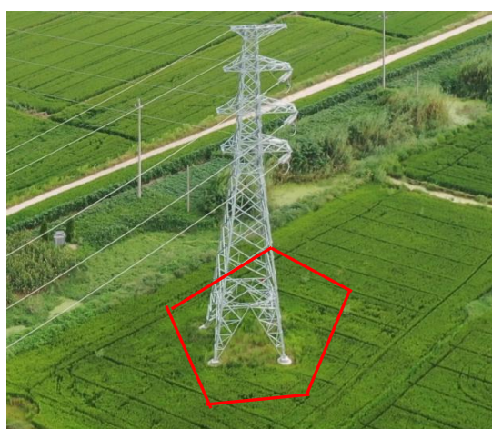
塔基区 T20 复耕 (2024 年 8 月)
