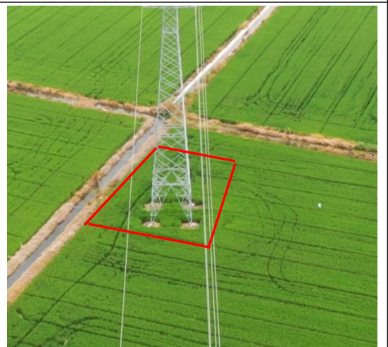
塔基区 T14 复耕 (2024 年 8 月)
