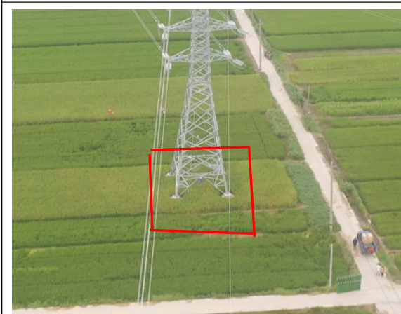
塔基区 T31 复耕 (2024 年 8 月)
