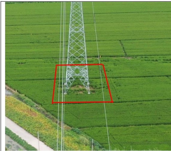
塔基区 T27 复耕 (2024 年 8 月)
