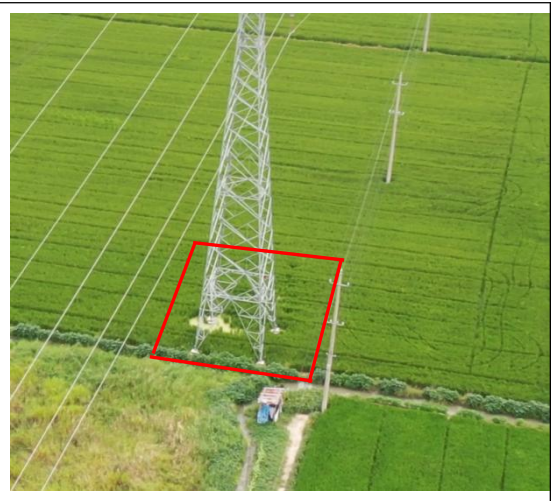
塔基区 T10 复耕 (2024 年 8 月)
