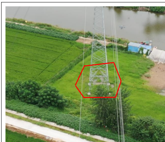
塔基区 T15 复耕 (2024 年 8 月)
