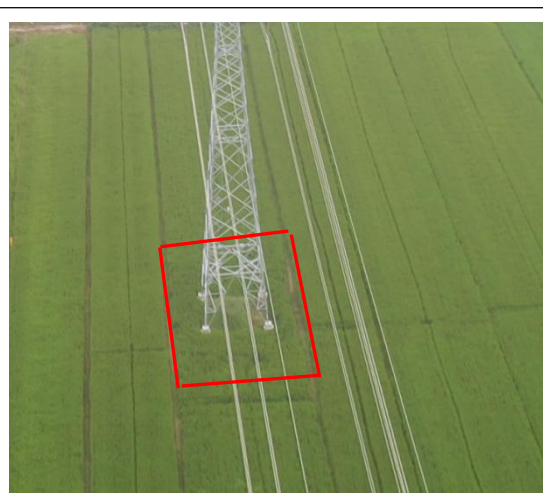
塔基区 T34 复耕 (2024 年 8 月)
