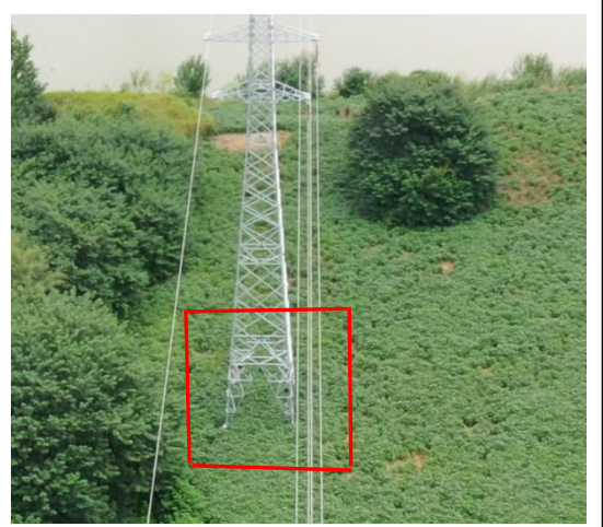
塔基区 T12 复耕 (2024 年 8 月)
