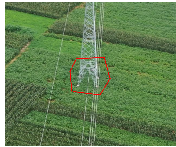
塔基区 T3 复耕（2024 年 8 月）
