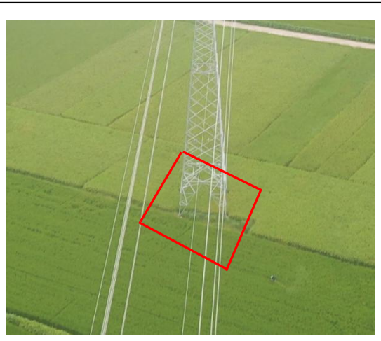
塔基区 T36 复耕 (2024 年 8 月)
