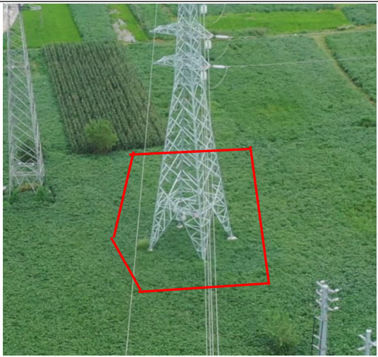
塔基区 T2 复耕（2024 年 8 月）
