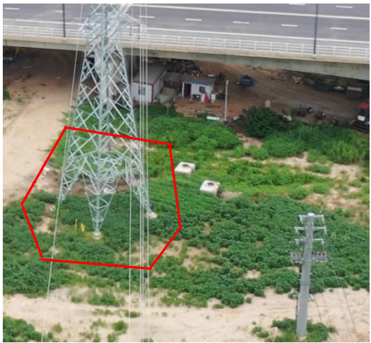
塔基区 T4 复耕 2024 年 8 月）
