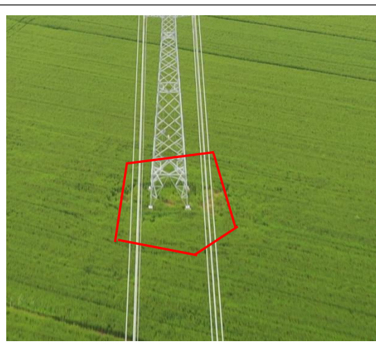
塔基区 T38 复耕 (2024 年 8 月)
