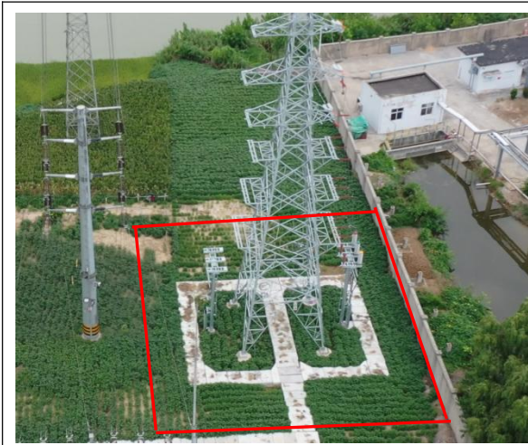
电缆施工区、塔基区 T1 复耕（2024 年 8 月）
