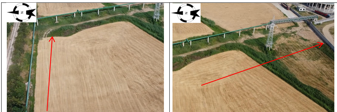
图 1.1-3 电缆线路工程沿线现状照片
