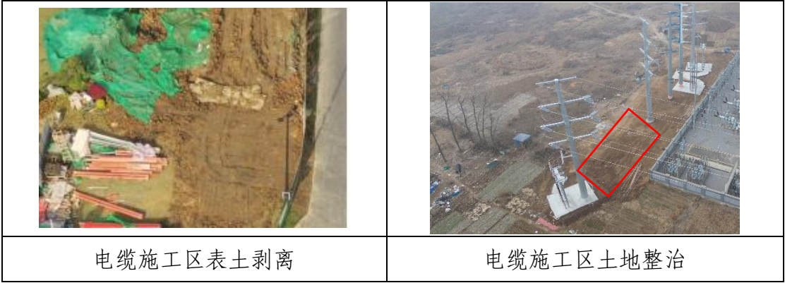
图 4-1 项目区工程措施实施情况
