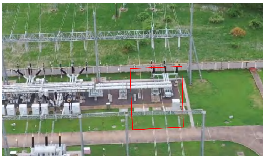
变电站区施工后期（2024.05）
