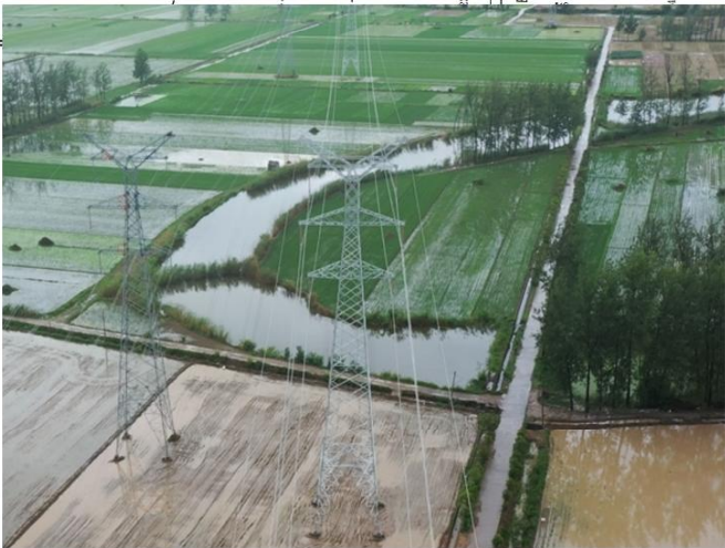
临时施工道路区复耕
