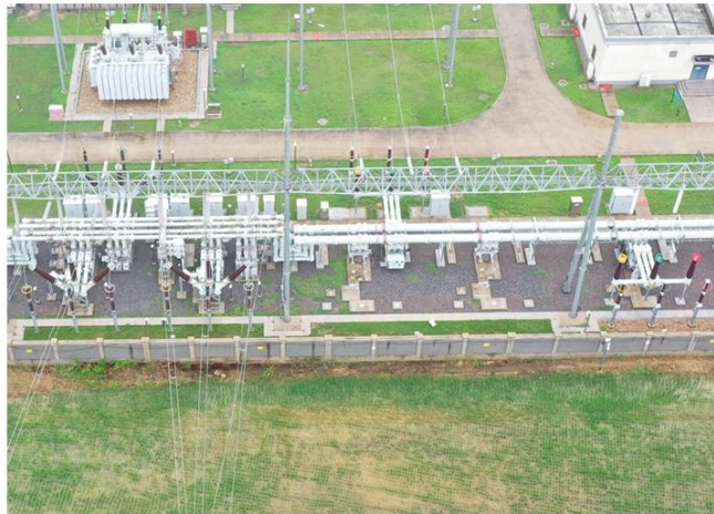
变电站区碎石压盖
