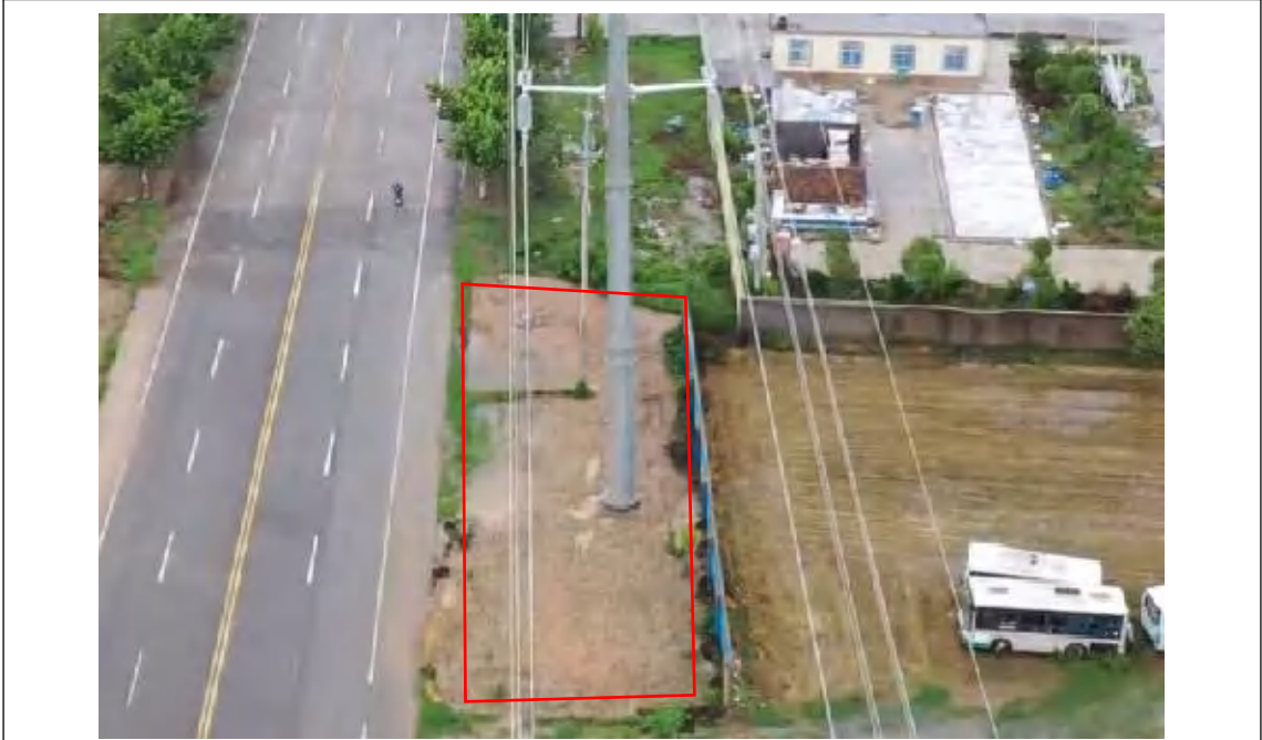
塔基及塔基施工区施工后期（2024.05）
