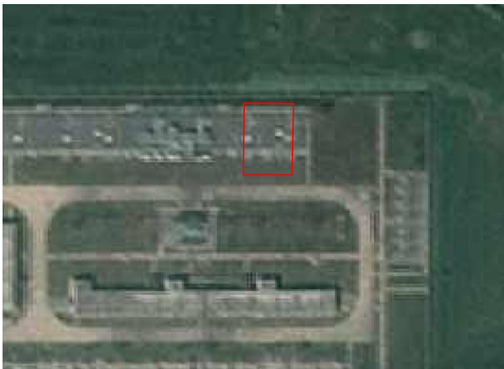
变电站区施工前（2023.12）
