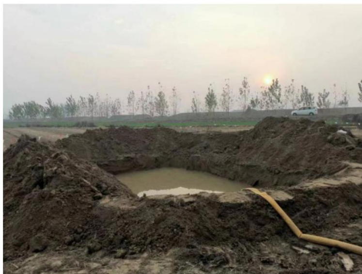
塔基及塔基施工区 泥浆沉淀池 (2023.12)
