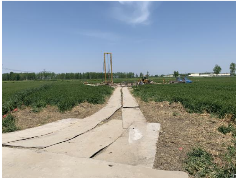
临时施工道路区 铺设钢板（2024.04） 图 4-3 临时措施防治效果
