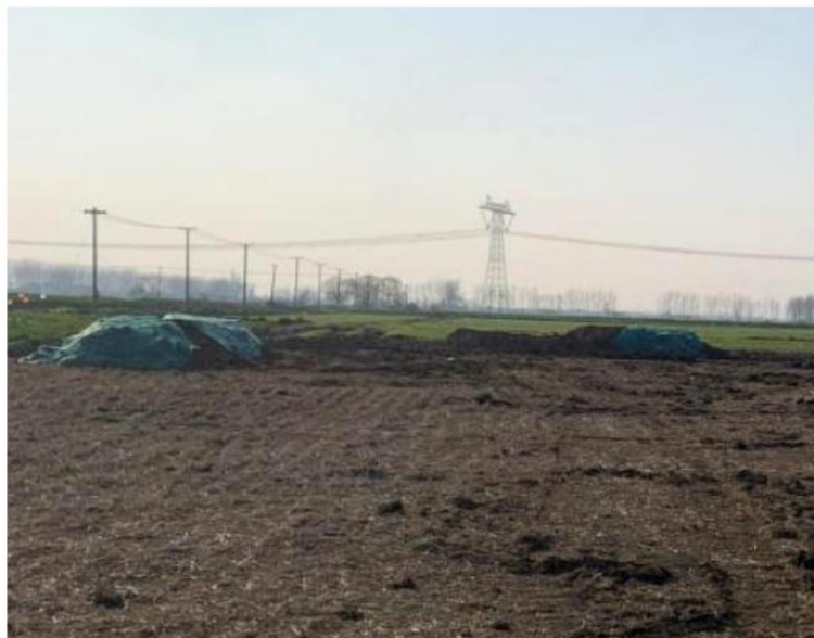
塔基及塔基施工区 表土剥离 (2024.02)
