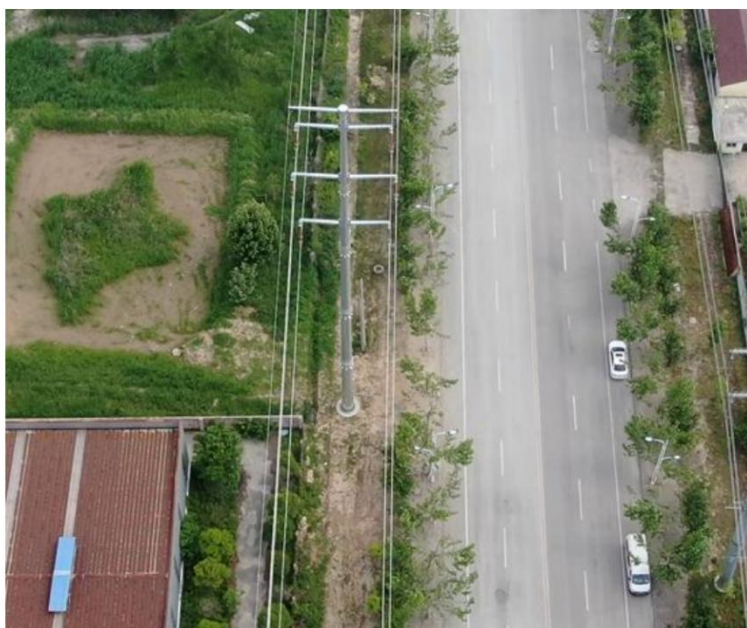
塔基及塔基施工区 撒播草籽 (2024.05)
