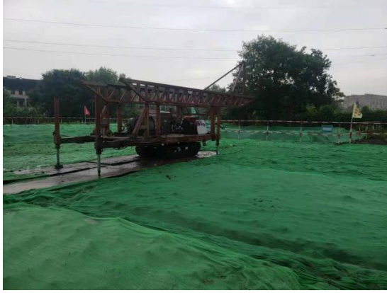
塔基及塔基施工区 防尘网苫盖（2023.12）
