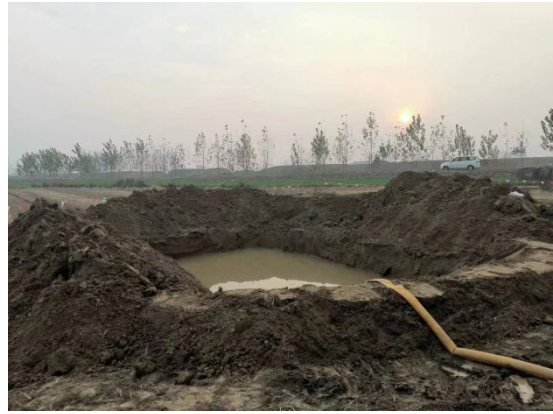
塔基及塔基施工区 泥浆沉淀池（2023.12）
