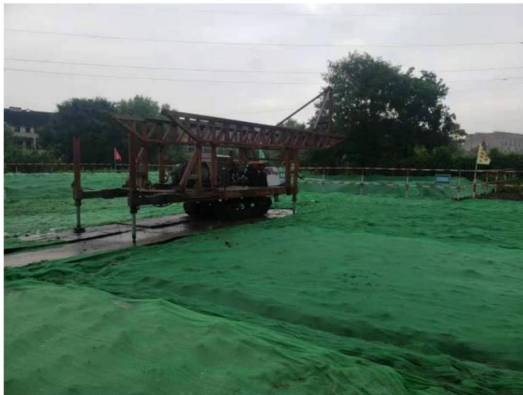
塔基及塔基施工区 防尘网苫盖 (2023.12)
