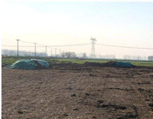
塔基及塔基施工区 表土剥离 (2024.02)
