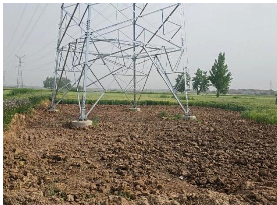
塔基及塔基施工区 土地整治 (2024.05)
