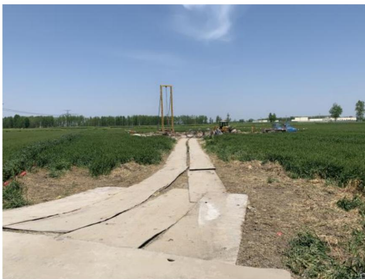
临时施工道路区 铺设钢板 (2024.04)
