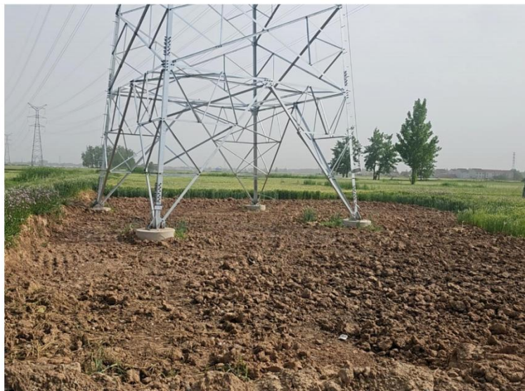
塔基及塔基施工区 土地整治 (2024.05)
