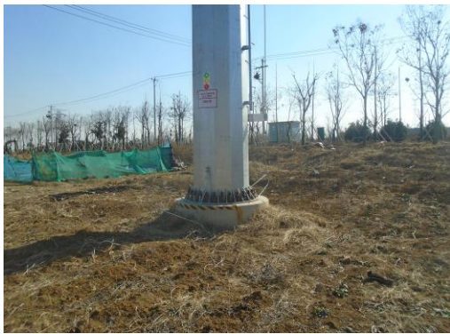
塔基周围生态恢复情况
