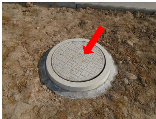
变电站化粪池
