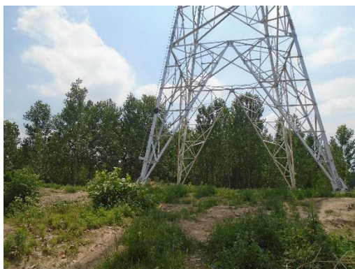
本工程线路塔基周围生态恢复示例
