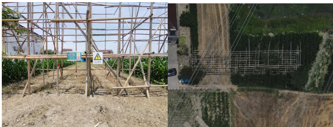
图1-16 输电线路跨越场布置照片
