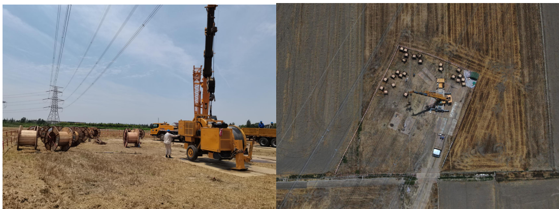
图1-15 输电线路牵张场布置照片
