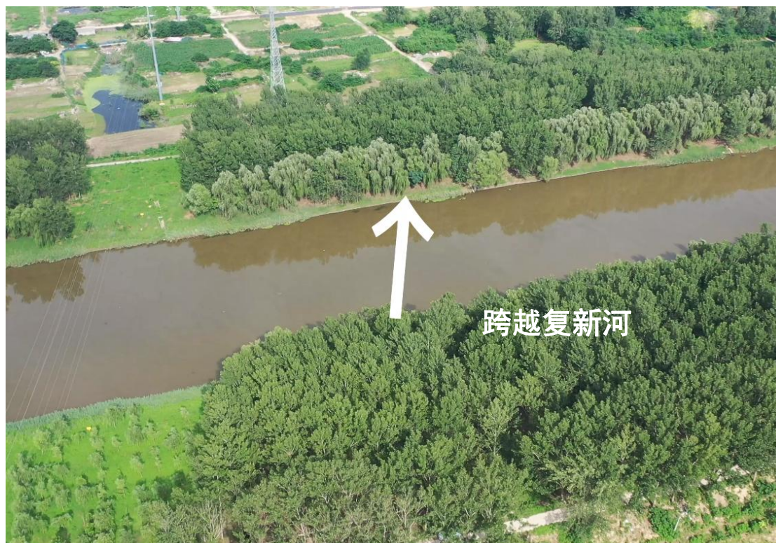
图 1-17 跨越处现场照片
