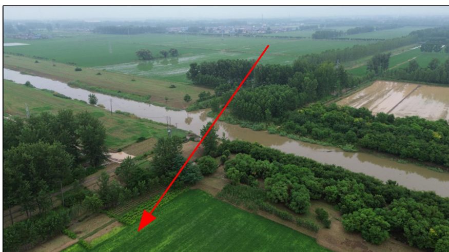
图 1.2-1 本工程跨越新龙河处现状照片
