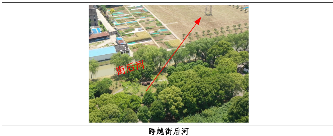
图 1.1-3 本工程架空线路跨越情况照片
