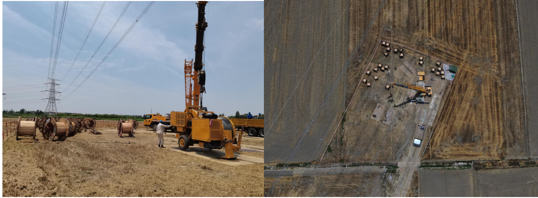
图1-8 输电线路牵张场布置照片
