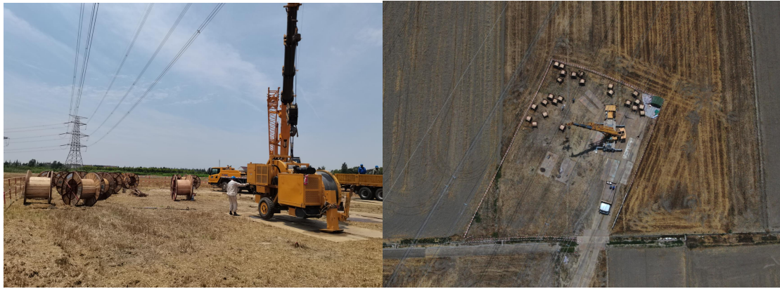
图1-6 输电线路牵张场布置照片
