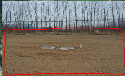
电缆施工区复耕
