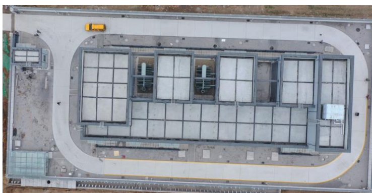
变电站区完工后 2024.01
