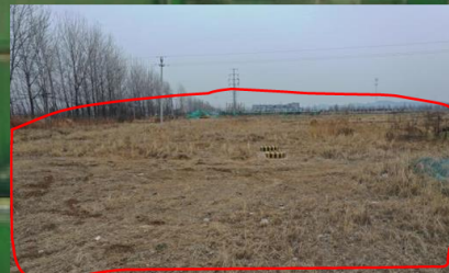
电缆施工区撒播草籽
