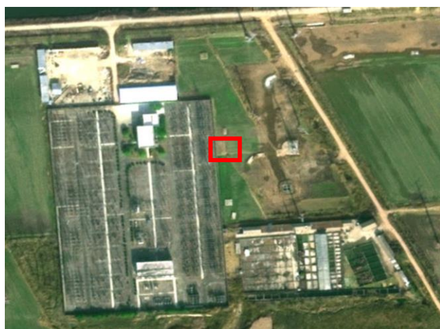
塔基区施工过程中 2023.01
