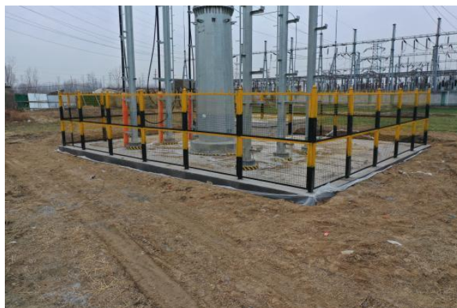
塔基区完工后 2024.01
