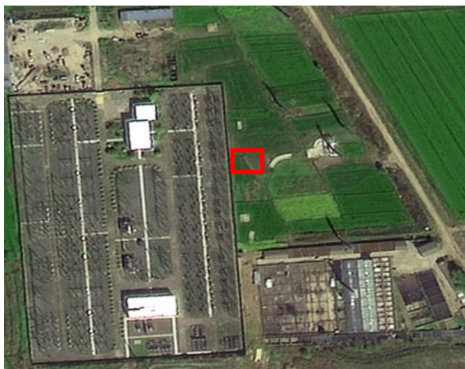
塔基区施工前期 2022.01
