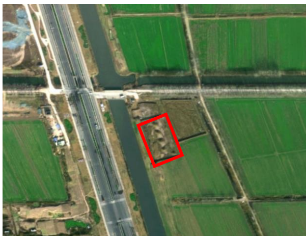
变电站区施工过程中 2023.01
