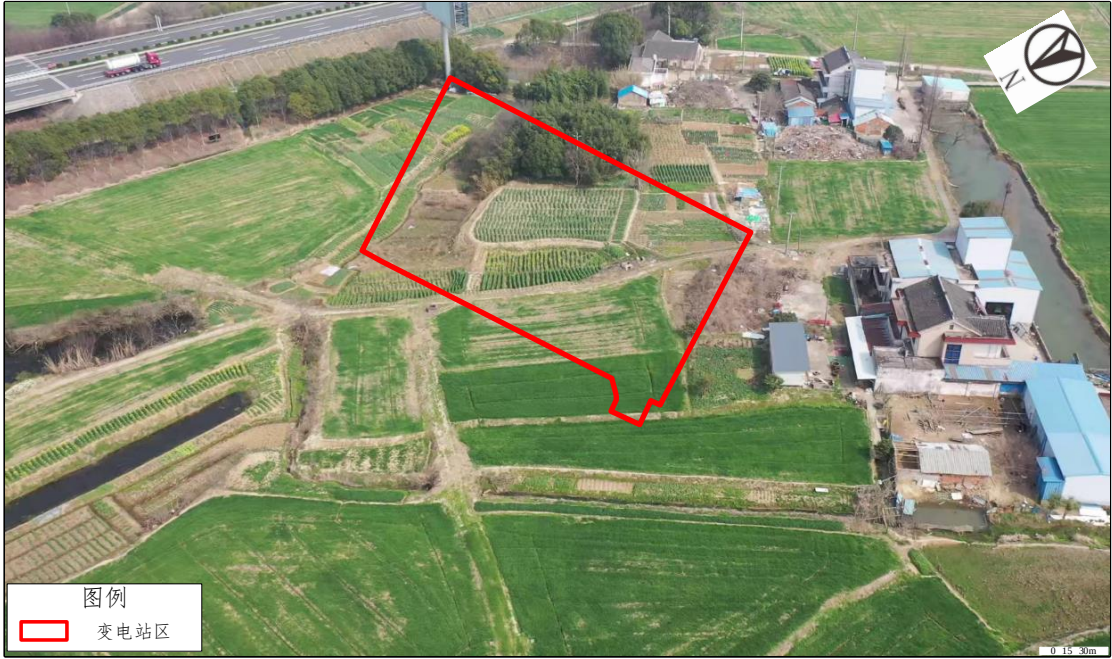
图 1.1-2 苏墅 110 千伏变电站工程站址现状
