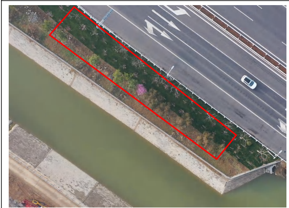
电缆施工区 撒播草籽+综合绿化 (2024.3)
