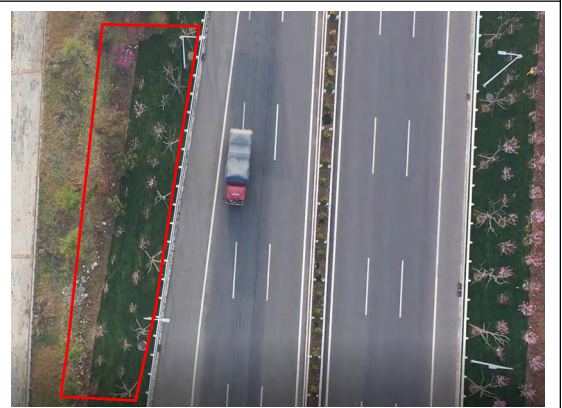
电缆施工区 撒播草籽+综合绿化 (2024.3)
