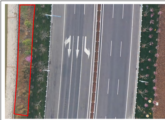
电缆施工区 撒播草籽 (2024.3)
