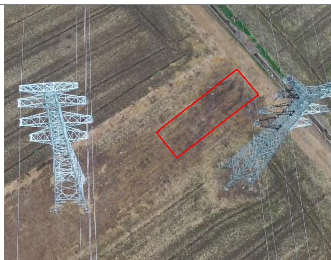
施工临时道路区 复耕 (2024.1)
