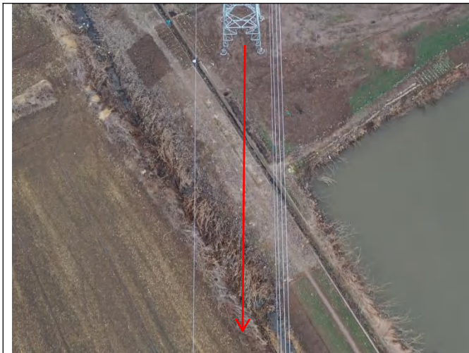
牵张场及跨越场区 复耕 (2024.1)
