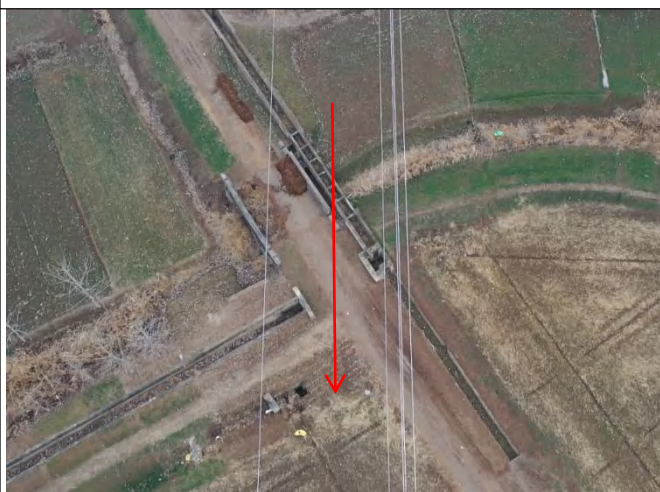
牵张场及跨越场区 复耕 (2024.1)
