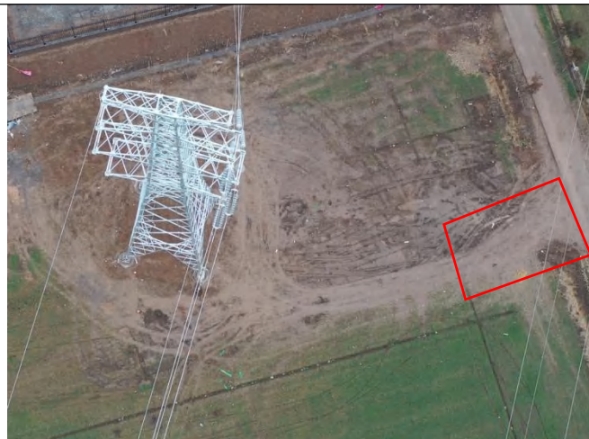
施工临时道路区 复耕 (2024.1)
