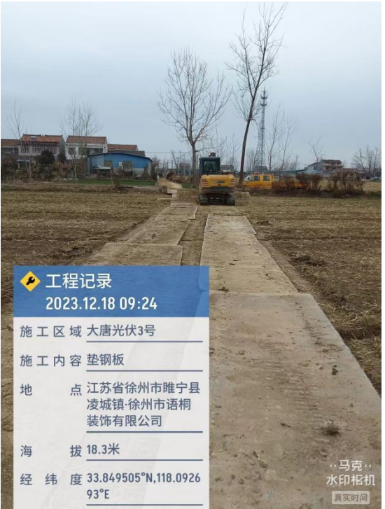
施工临时道路区 铺设钢板（2023.12） 图 4-3 临时措施防治效果
