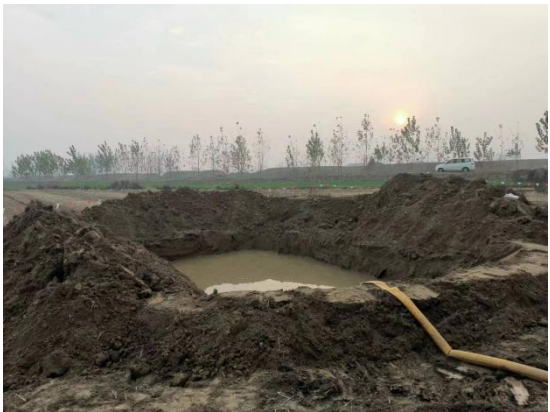
塔基及塔基施工区 泥浆沉淀池（2023.11）
