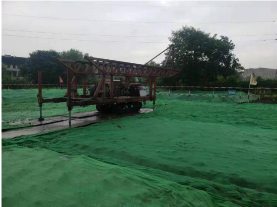
塔基及塔基施工区 密目网苫盖（2023.11）
