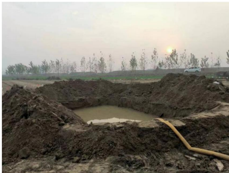
塔基及塔基施工区 泥浆沉淀池 (2023.11)
