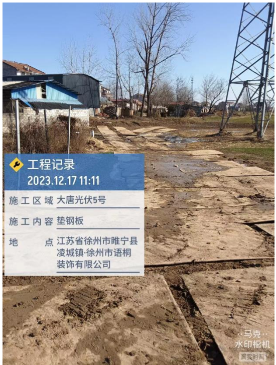
施工临时道路区 铺设钢板（2023.12） 图 4-3 临时措施防治效果
