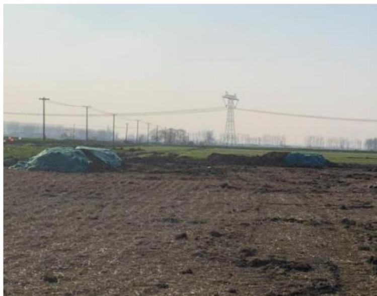
塔基及塔基施工区 表土剥离 (2023.11)
