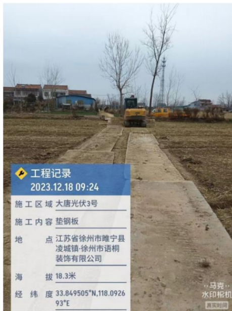
施工临时道路区 铺设钢板 (2023.12)
