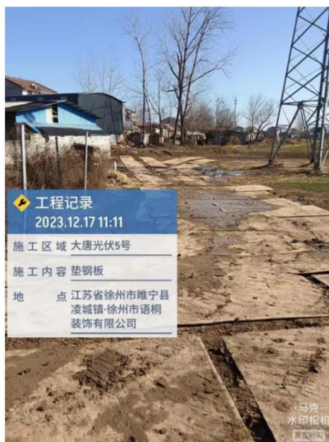
施工临时道路区 铺设钢板 (2023.12)
