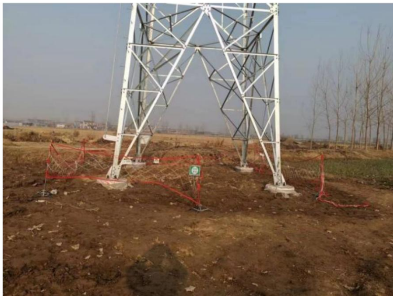
塔基及塔基施工区 土地整治 (2023.12)
