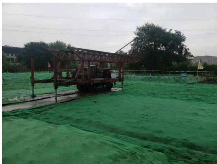
塔基及塔基施工区 密目网苫盖 (2023.11)
