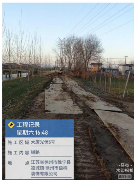
施工临时道路区 铺设钢板 (2023.12)
