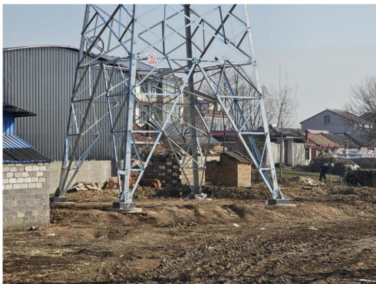
塔基及塔基施工区 撒播草籽 (2024.01)
