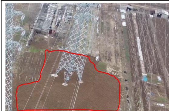
塔基区 T15 复耕 (2024 年 3 月)
