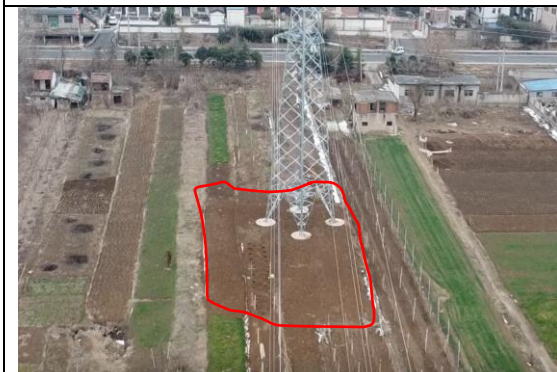
塔基区 T19 复耕 (2024 年 3 月)
