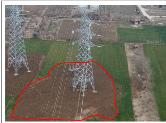
塔基区 T13 复耕 (2024 年 3 月)
