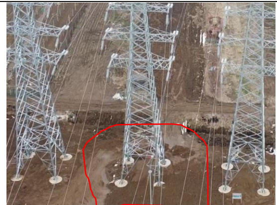
塔基区 T14 复耕 (2024 年 3 月)
