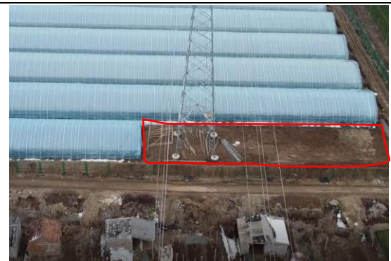
塔基区 T18 复耕 (2024 年 3 月)
