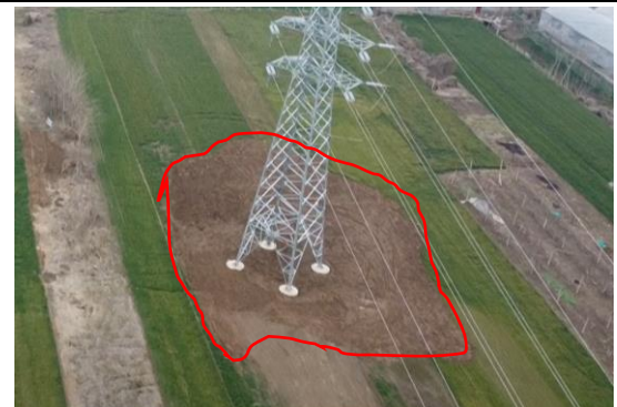
塔基区 T16 复耕 (2024 年 3 月)
