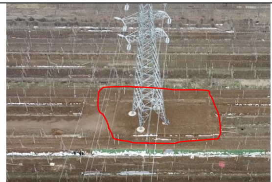
塔基区 T20 复耕 (2024 年 3 月)
