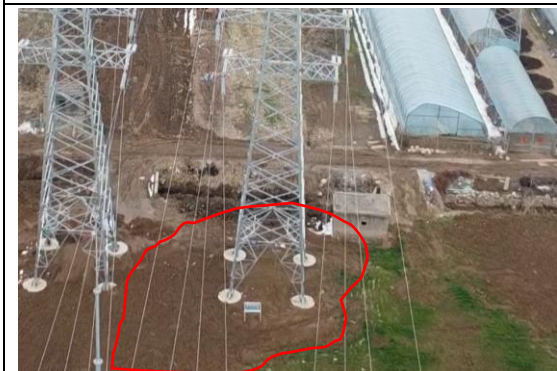
塔基区 T17 复耕 (2024 年 3 月)
