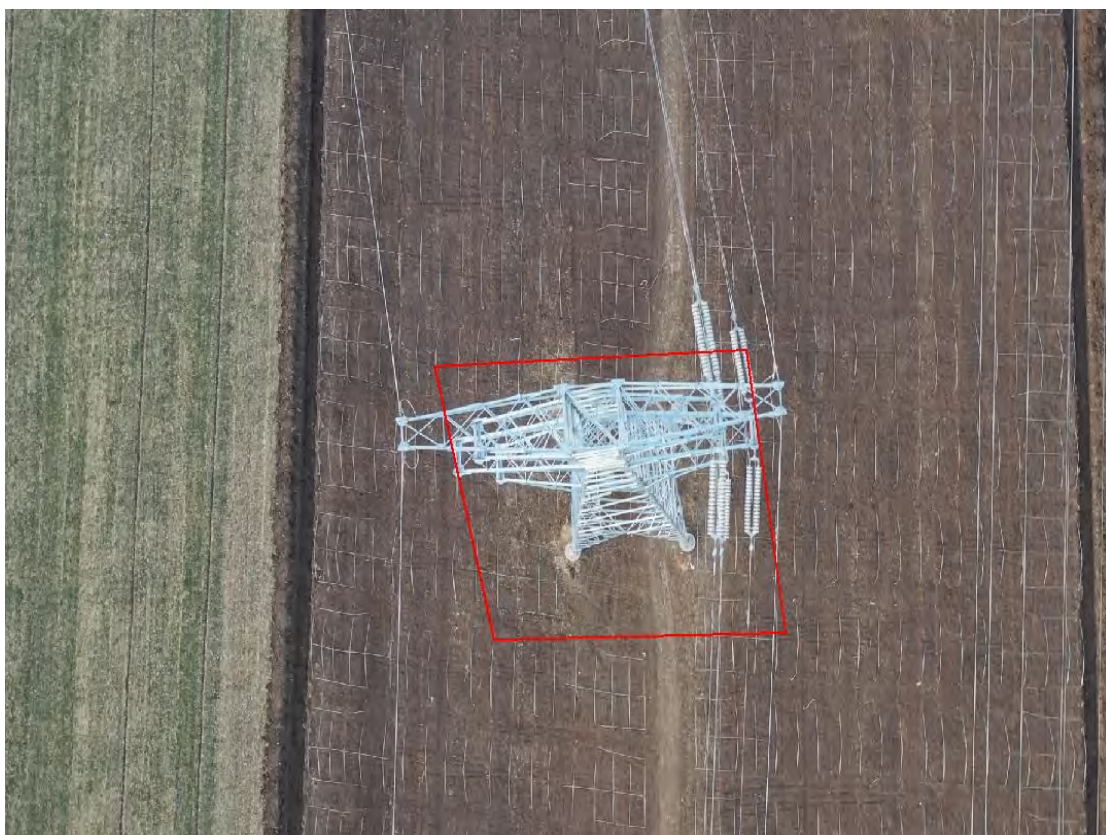
施工前（塔基区 T8 杆塔、2024 年 1 月）
