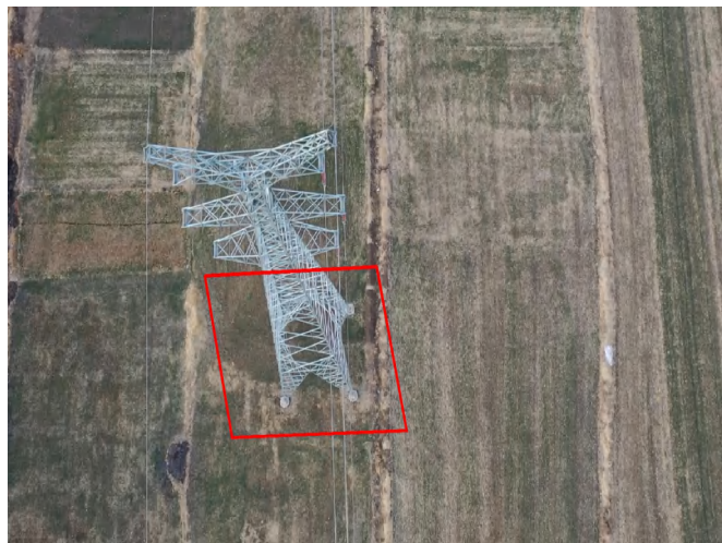
塔基区 T2 杆塔 复耕 (2024.1)
