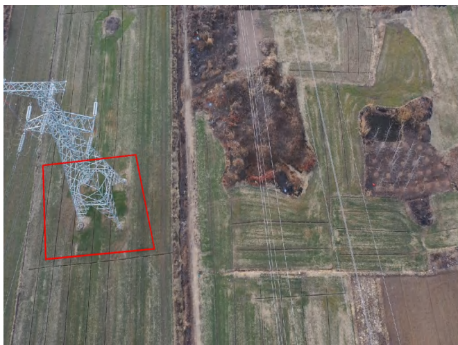
塔基区 T19 杆塔 复耕 (2024.1)
