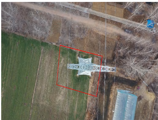
塔基区 T9 杆塔 复耕 (2024.1)
