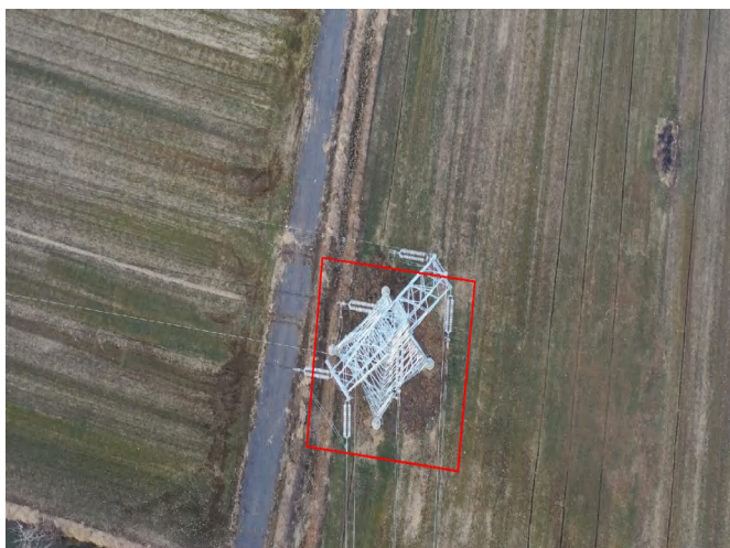
塔基区 T15 杆塔 复耕 (2024.1)
