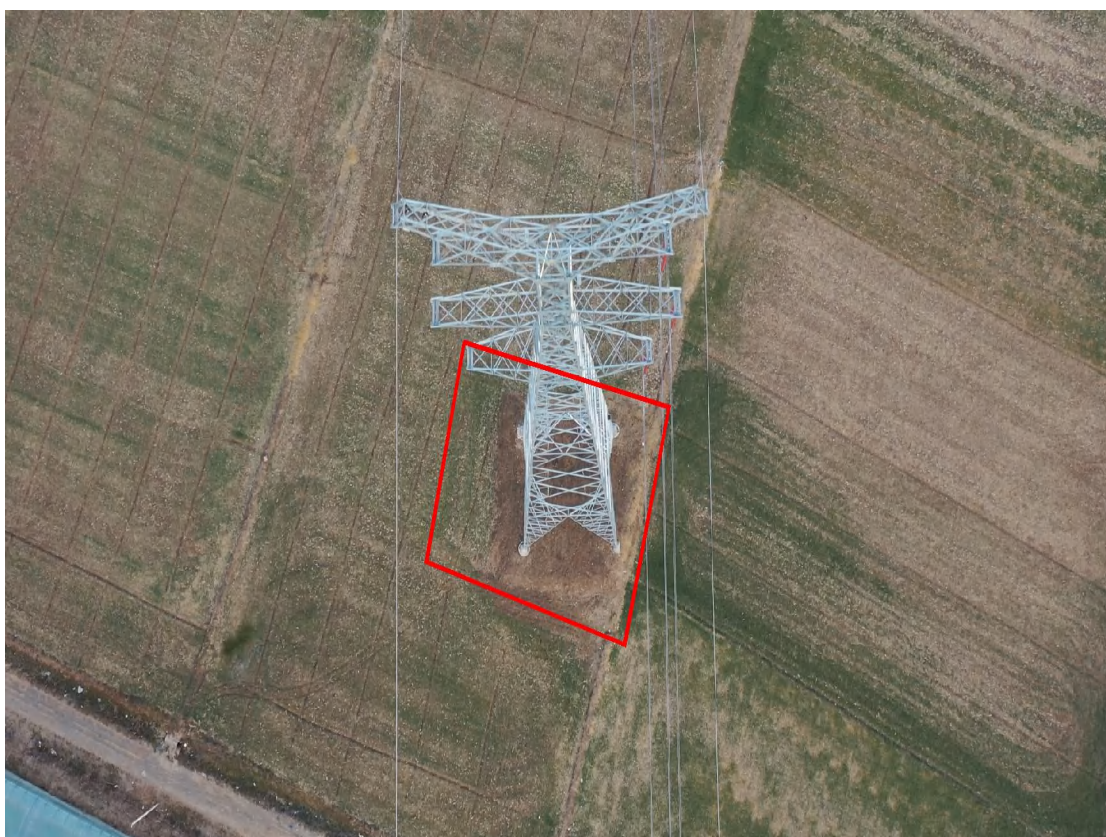
施工后（塔基区 T5 杆塔、2023 年 12 月）
