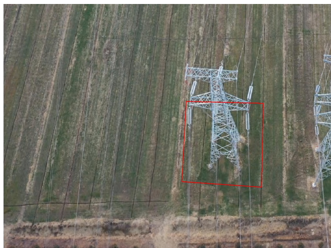
塔基区 T18 杆塔 复耕 (2024.1)
