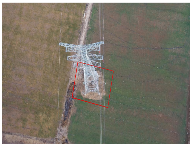
塔基区 T12 杆塔 复耕 (2024.1)
