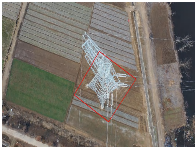
塔基区 T10 杆塔 复耕 (2024.1)
