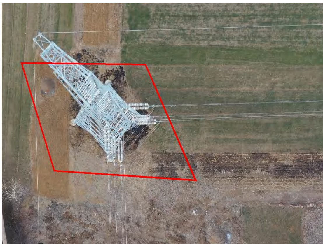
施工后（塔基区 T5 杆塔、2024 年 1 月）
