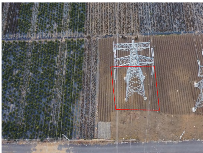
塔基区 T17 杆塔 复耕 (2024.1)
