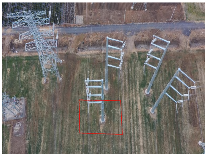
塔基区 T16 杆塔 复耕 (2024.1)
