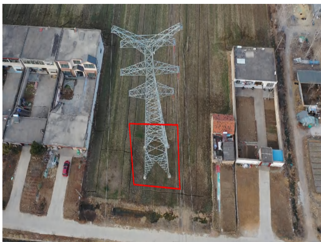
塔基区 T3 杆塔 复耕 (2024.1)
