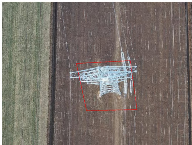
塔基区 T8 杆塔 复耕 (2024.1)
