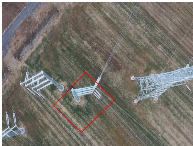
塔基区 T14 杆塔 复耕 (2024.1)
