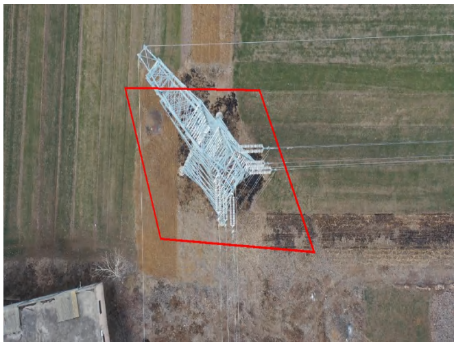
塔基区 T5 杆塔 复耕 (2024.1)
