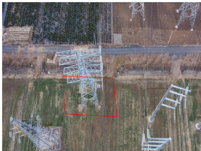
塔基区 T20 杆塔 复耕 (2024.1)
