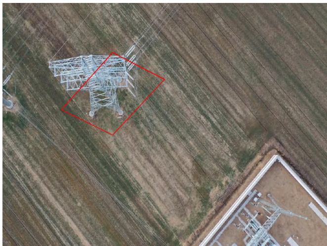
塔基区 T1 杆塔 复耕 (2024.1)
