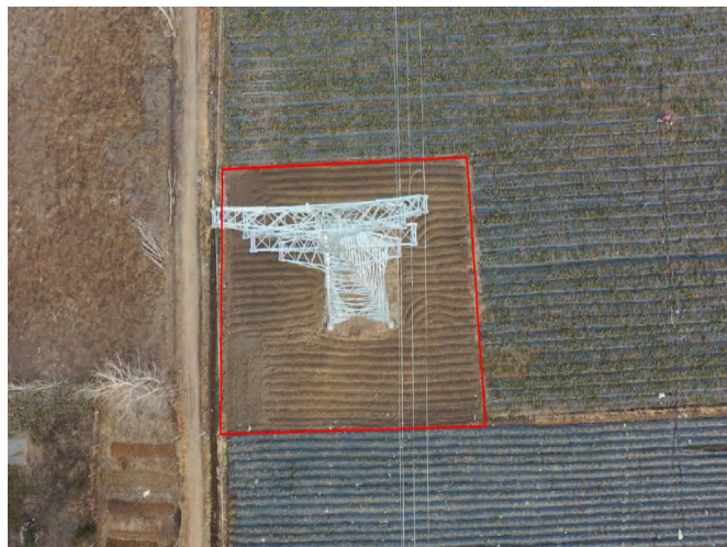
塔基区 T6 杆塔 复耕 (2024.1)
