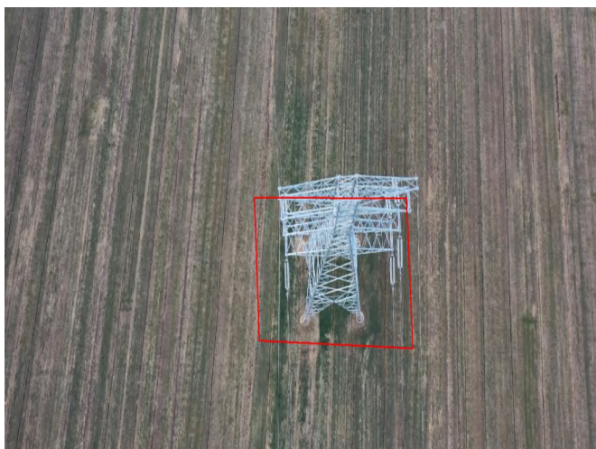
塔基区 T21 杆塔 复耕 (2024.1)
