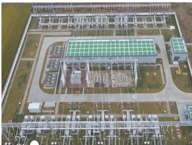
变电站区铺植草皮 (2024.1)
