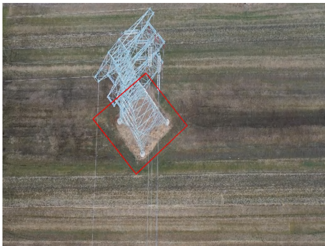
塔基区 T7 杆塔 复耕 (2024.1)
