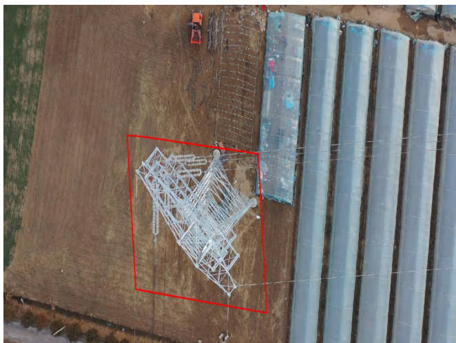
塔基区 T13 杆塔 复耕 (2024.1)
