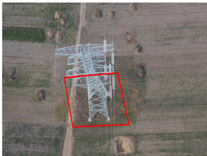
塔基区 T4 杆塔 复耕 (2024.1)
