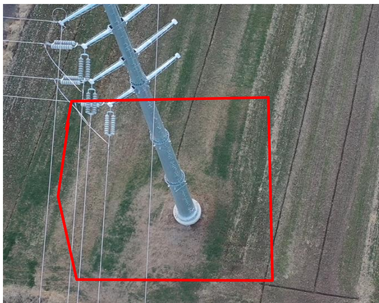
塔基区复耕现状（2024.1）
