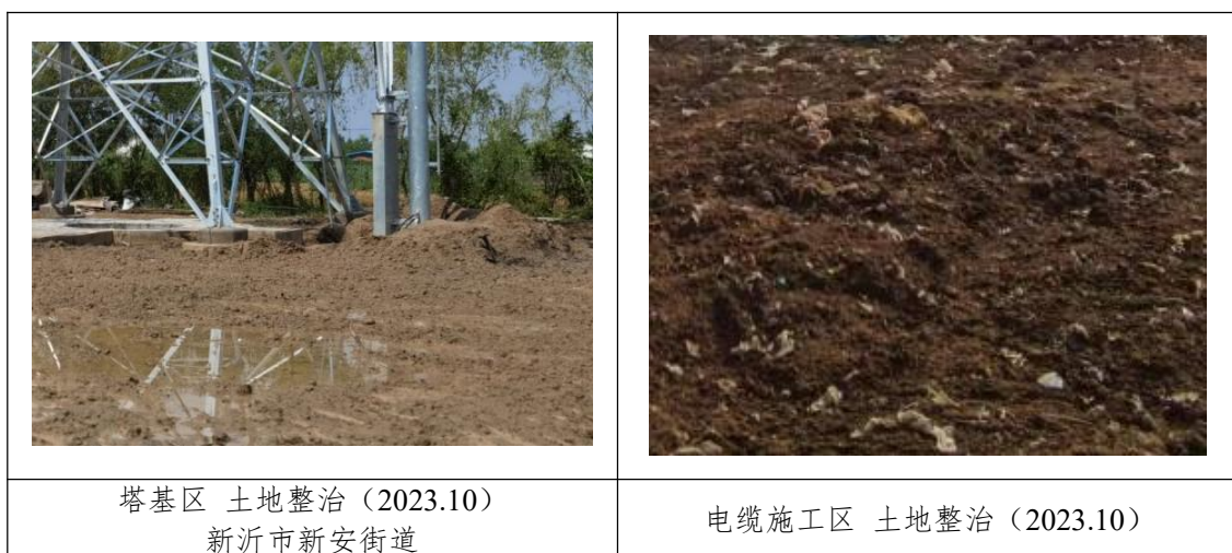
图 4-1 工程措施实施照片
