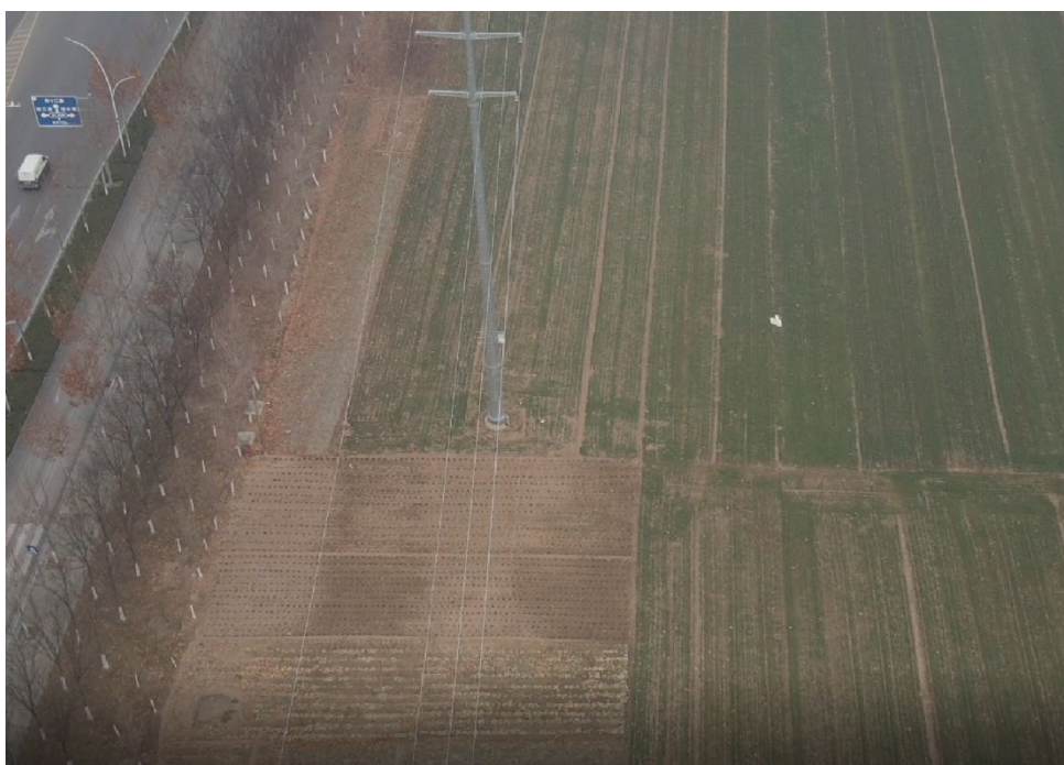
110kV 大振 8G2 线#38 塔建设后影像
