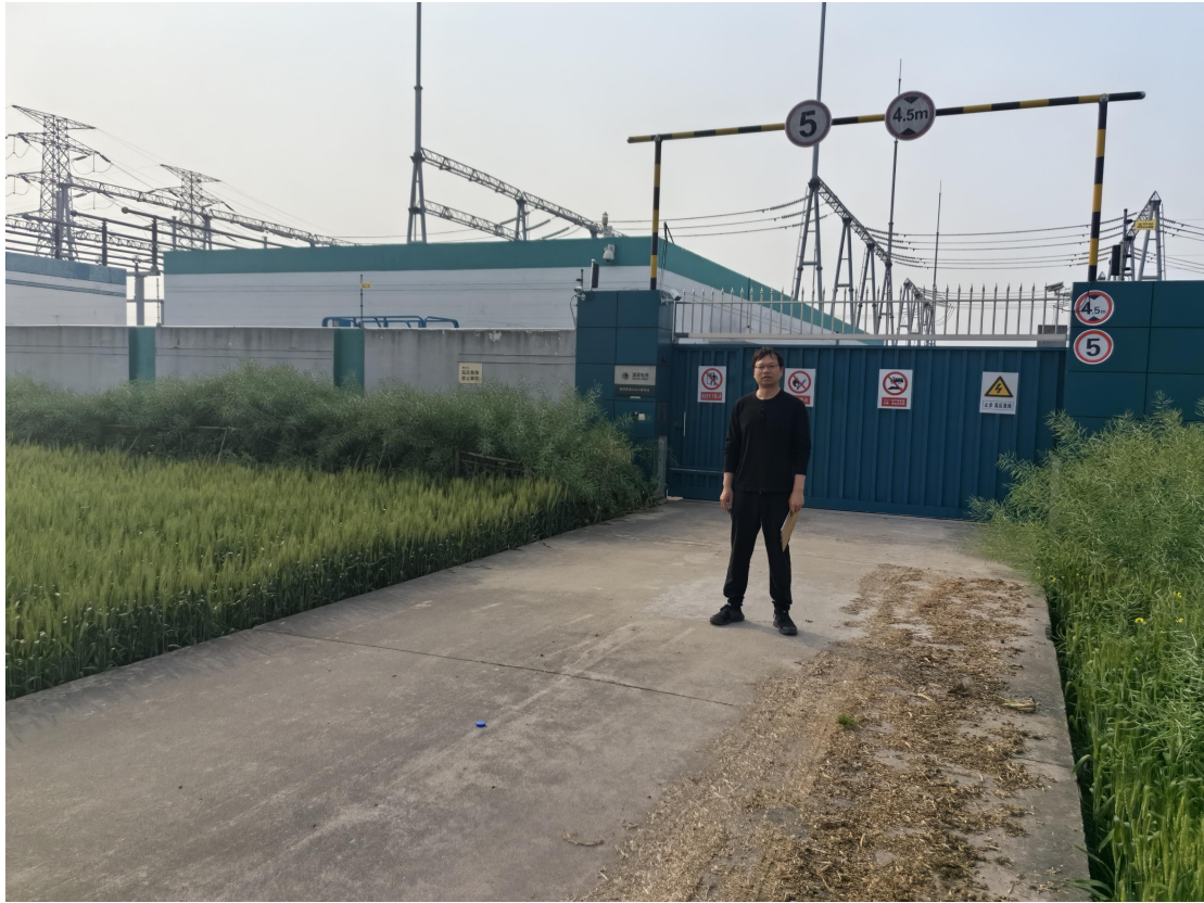
编制主持人项目现场踏勘照片（常青 220kV 变电站）
