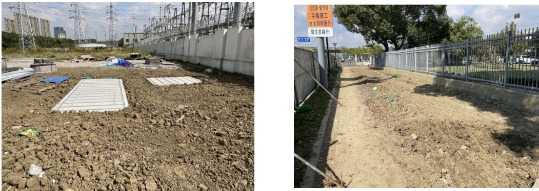
电缆施工区土地整治（2023.11）
