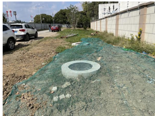
电缆施工区密目网苫盖 (2023.9)
