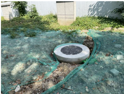
电缆施工区密目网苫盖 (2023.9)
