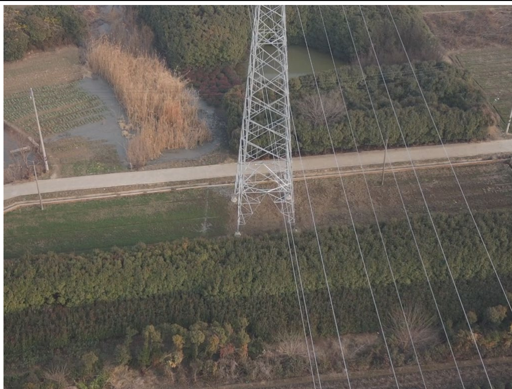
35kV 新能 358 线#8/110kV 典金 9Y8 线#31 塔建设后影像
