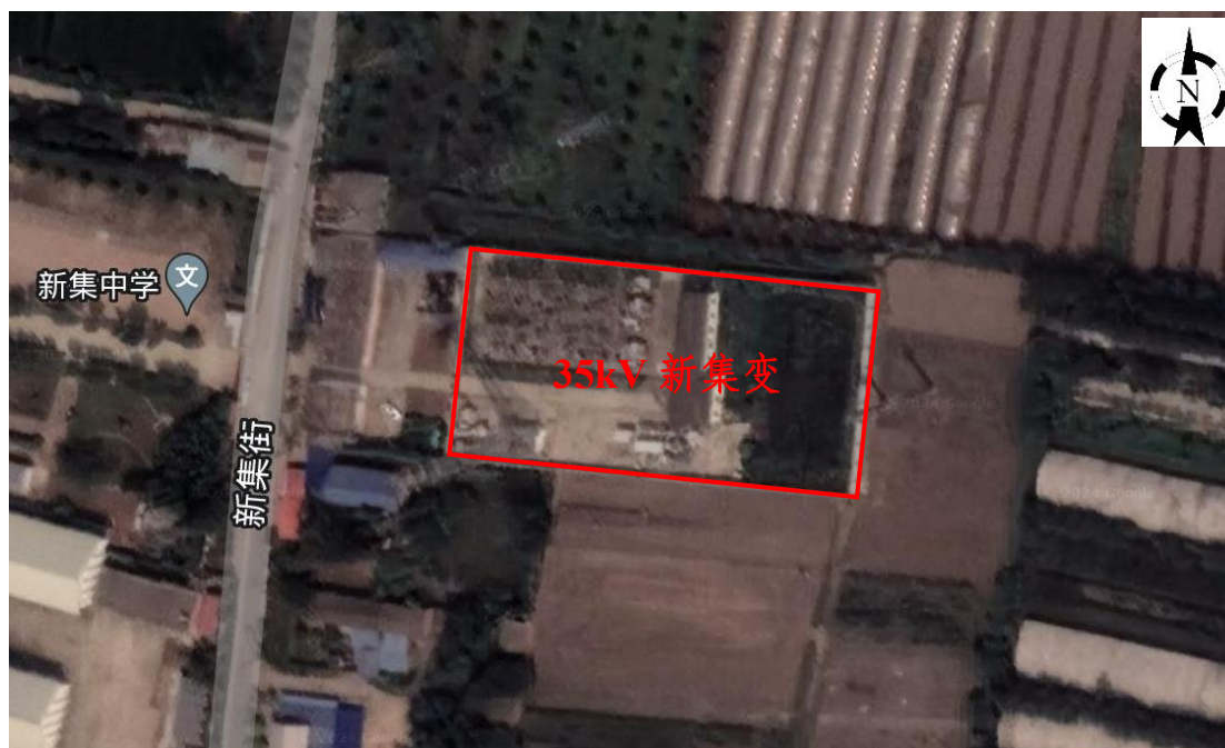
图 1.1-1 新集 35 千伏变电站施工前遥感影像图
