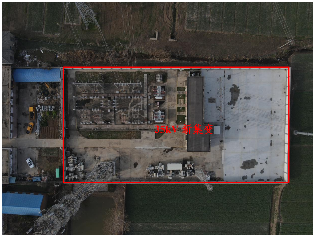
图 1.1-2 新集 35 千伏变电站站址现状
