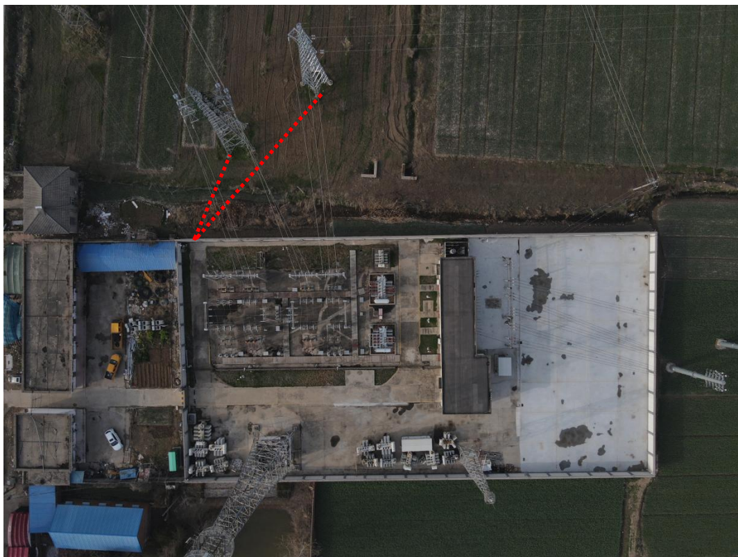
图 1.1-5 线路工程沿线现状照片
