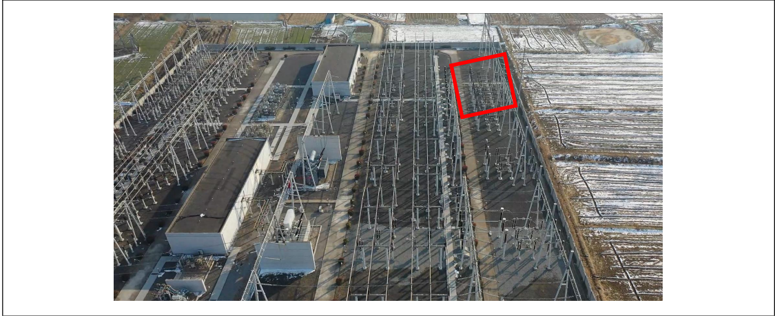
图 1.1-2 临湖 220 千伏变电站 110 千伏间隔改造工程现状照片（红框内为本期改造间隔）
