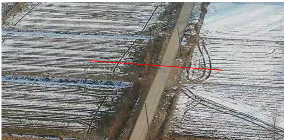
本工程跨越大众路现状照片
