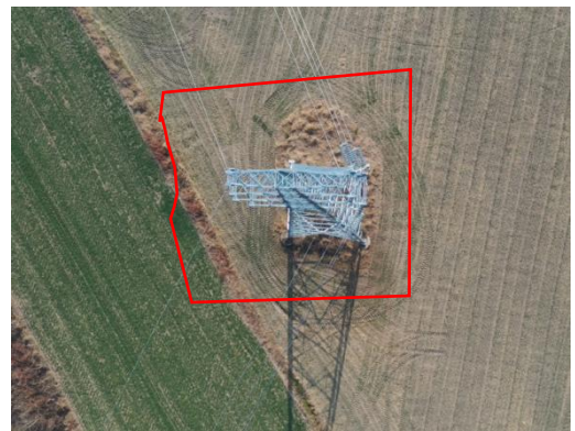
塔基区 T44 复耕 (2023.12)
