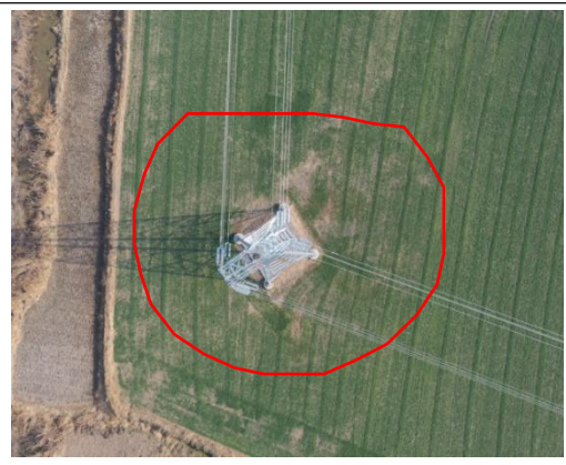
塔基区 T2 复耕 (2023.12)
