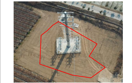
塔基区 T42 复耕 (2023.12)
