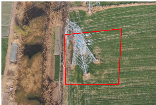
塔基区 T7 复耕 (2023.12)
