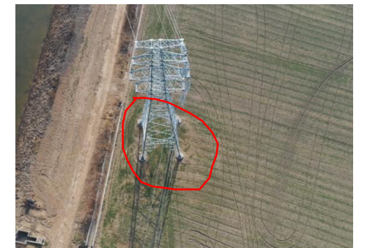
塔基区 T41 复耕 (2023.12)
