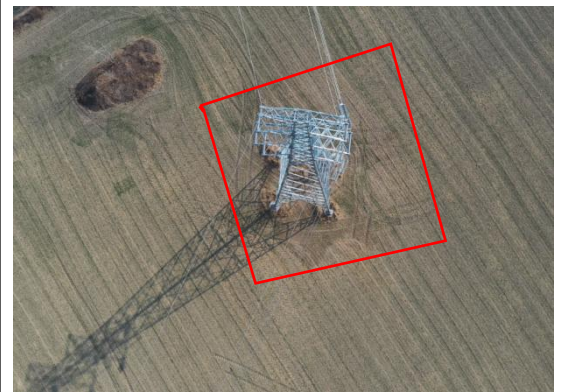
塔基区 T46 复耕 (2023.12)
