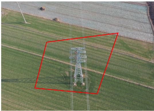
塔基区 T5 复耕 (2023.12)
