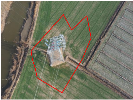
塔基区 T3 复耕 (2023.12)
