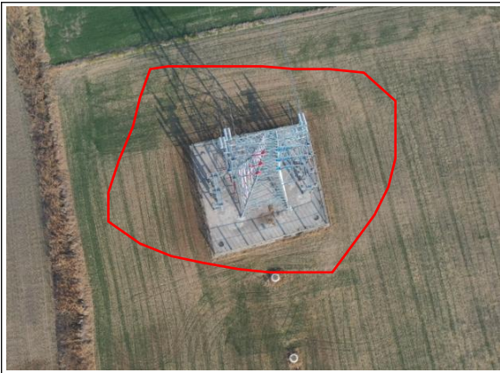
塔基区 T1 复耕 (2023.12)
