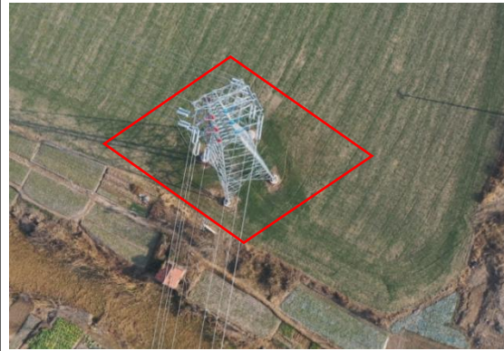
塔基区 T6 撒播草籽 (2023.12)
