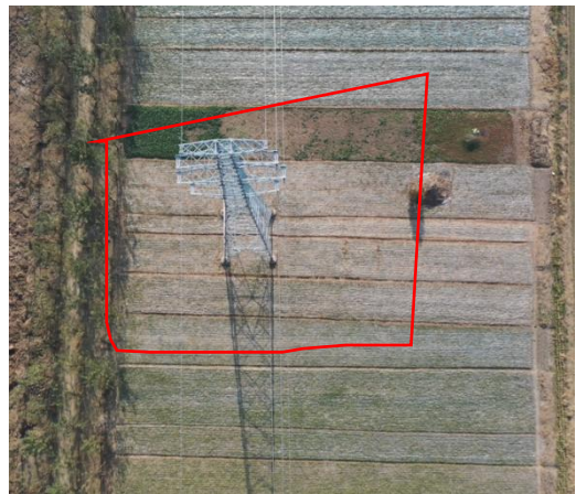
塔基区 T38 复耕 (2023.12)
