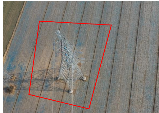
塔基区 T8 复耕 (2023.12)
