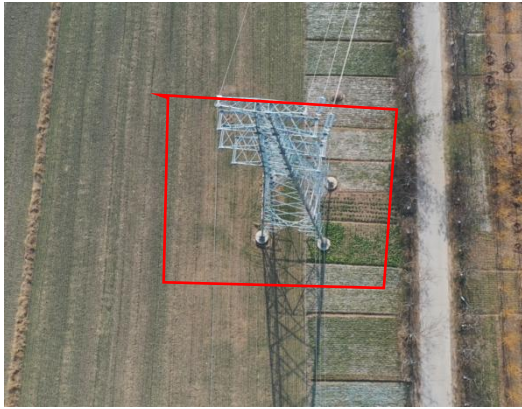
塔基区 T36 复耕 (2023.12)
