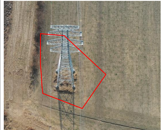
塔基区 T40 复耕 (2023.12)
