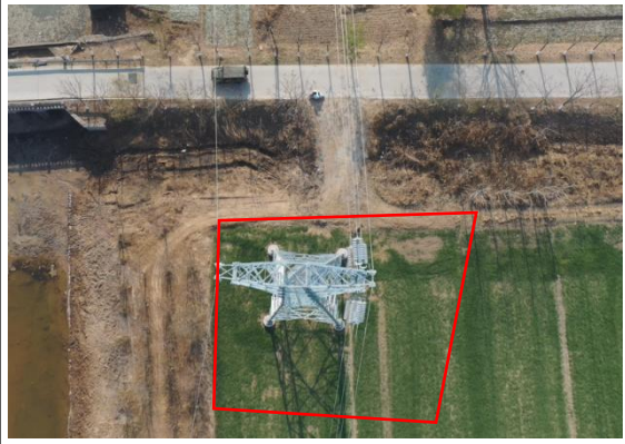
塔基区 T37 复耕 (2023.12)
