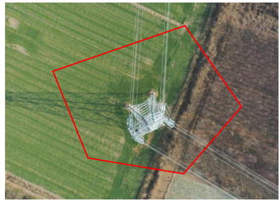
塔基区 T4 复耕 (2023.12)
