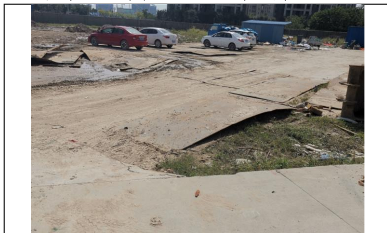
临时施工道路区（2021年6月21日）
