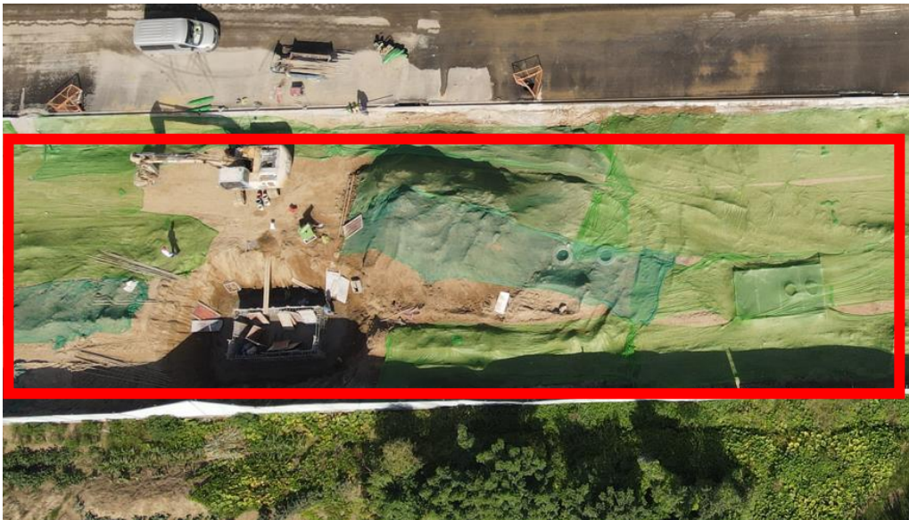
图 4.3-2 电缆施工区密目网苫盖
