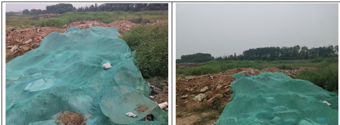
临时堆土区（2022年9月25日）
