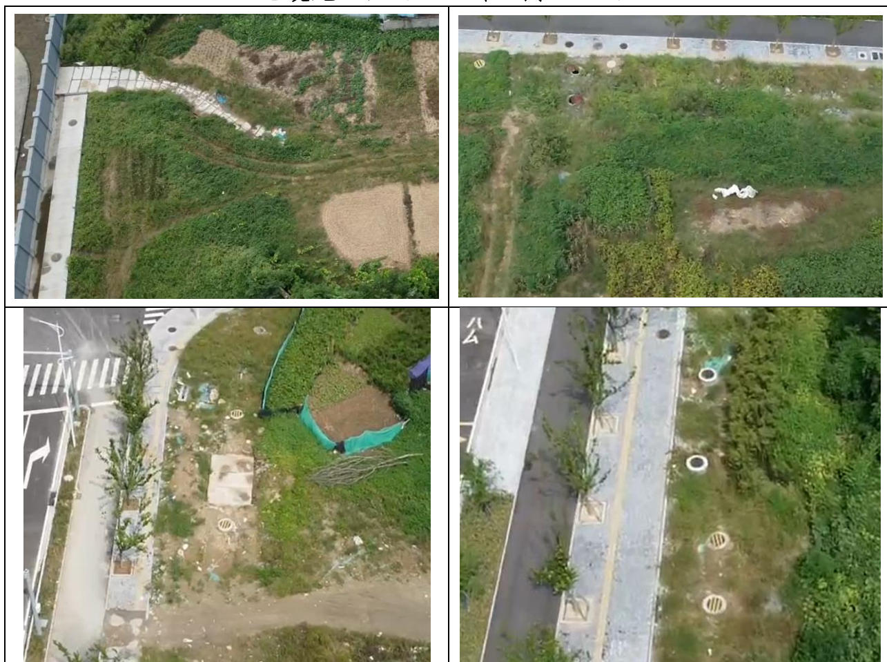
电缆施工区（2023 年 9 月 28 日）
