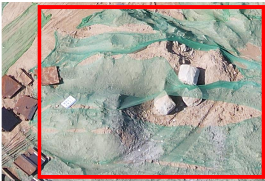
图 4.3-4 临时堆土区密目网苫盖
