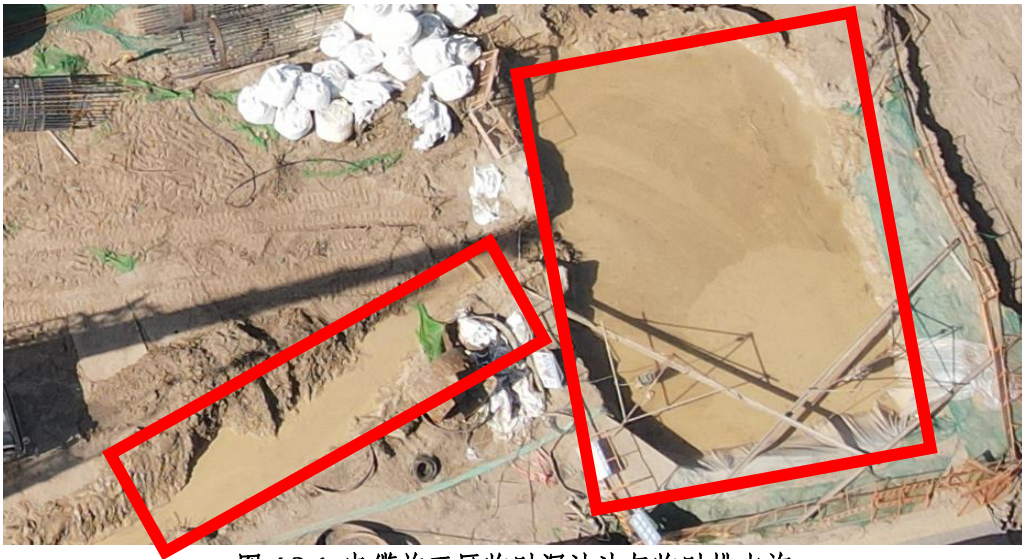
图 4.3-1 电缆施工区临时沉沙池与临时排水沟
