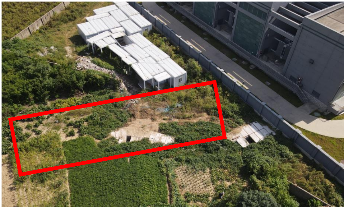
图 4.2-1 变电站出线电缆处植物措施
