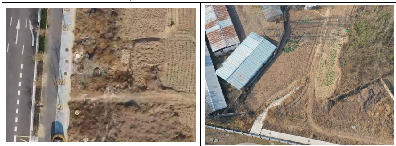
电缆施工区（2023 年 12 月 8 日）
