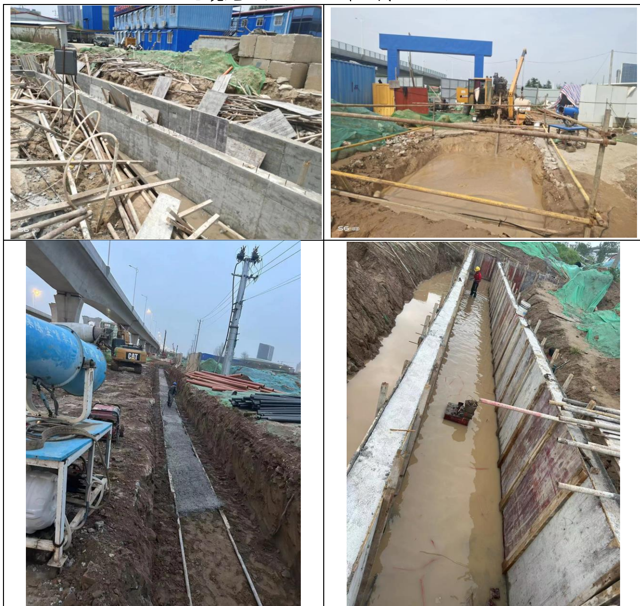
电缆施工区（2022年9月25日）
