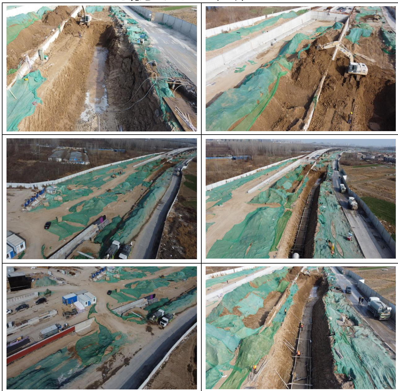
电缆施工区（2021年6月21日）
