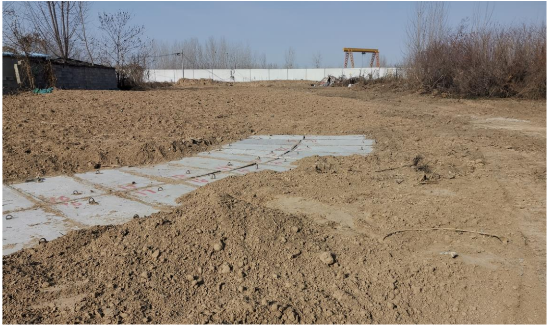
图 4.1-1 变电站出线电缆处土地整治
