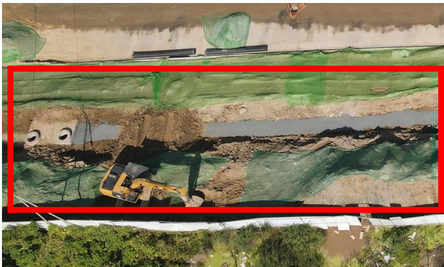
图 4.3-3 电缆施工区密目网苫盖
