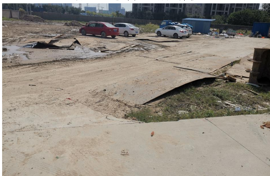
图 4.3-5 施工临时道路区钢板铺设
