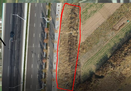
电缆施工区撒播草籽
