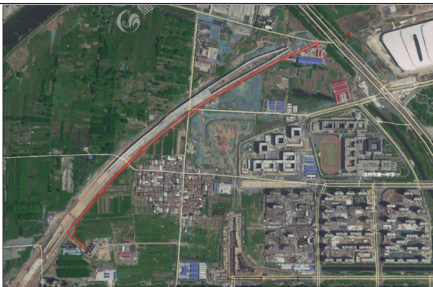
项目施工过程中 2022.07
