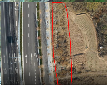
电缆施工区撒播草籽
