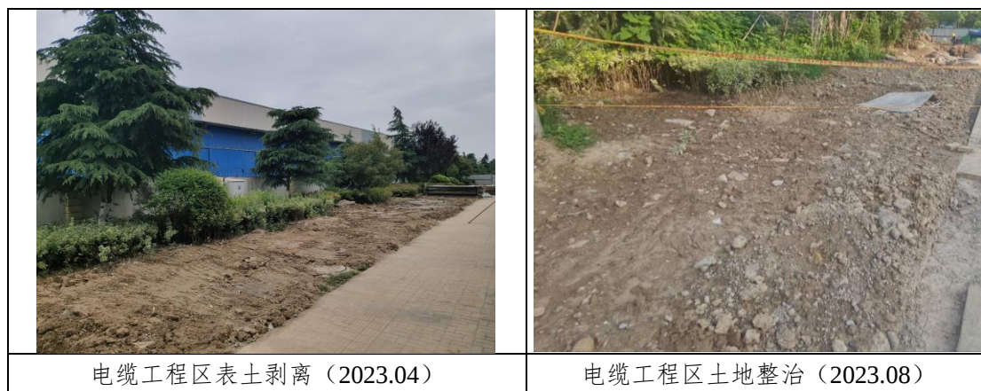
图 4-1 水土保持工程措施实施情况
