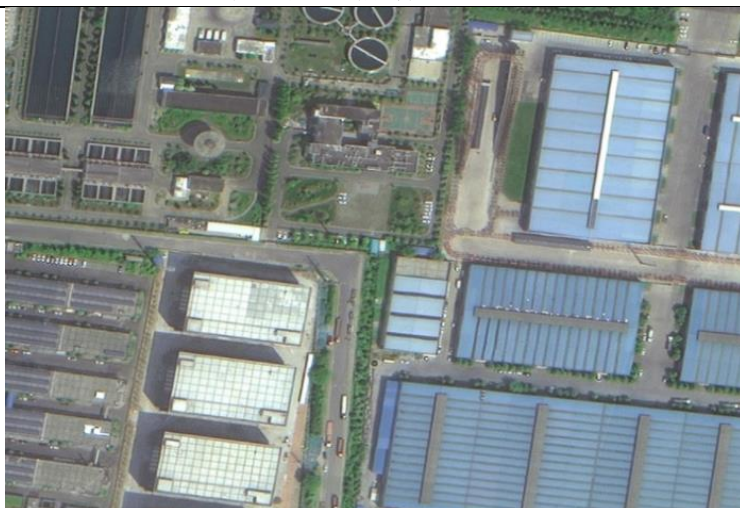
项目施工过程中 2023.05
