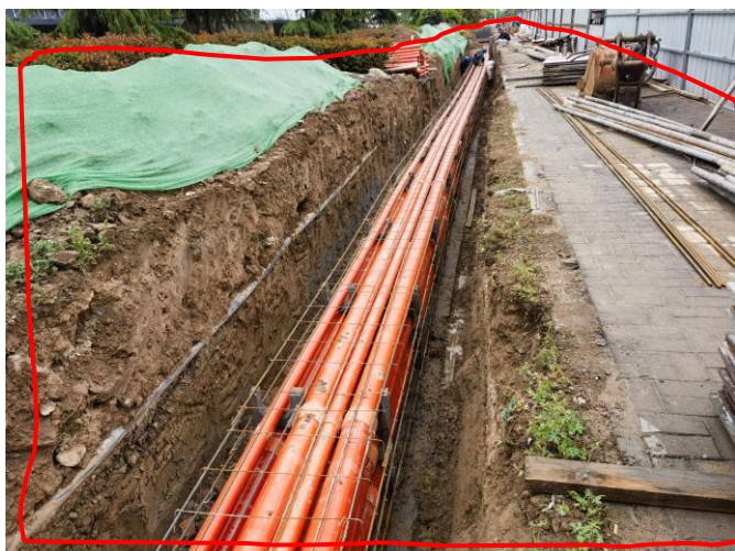
项目施工过程中 2023.05
