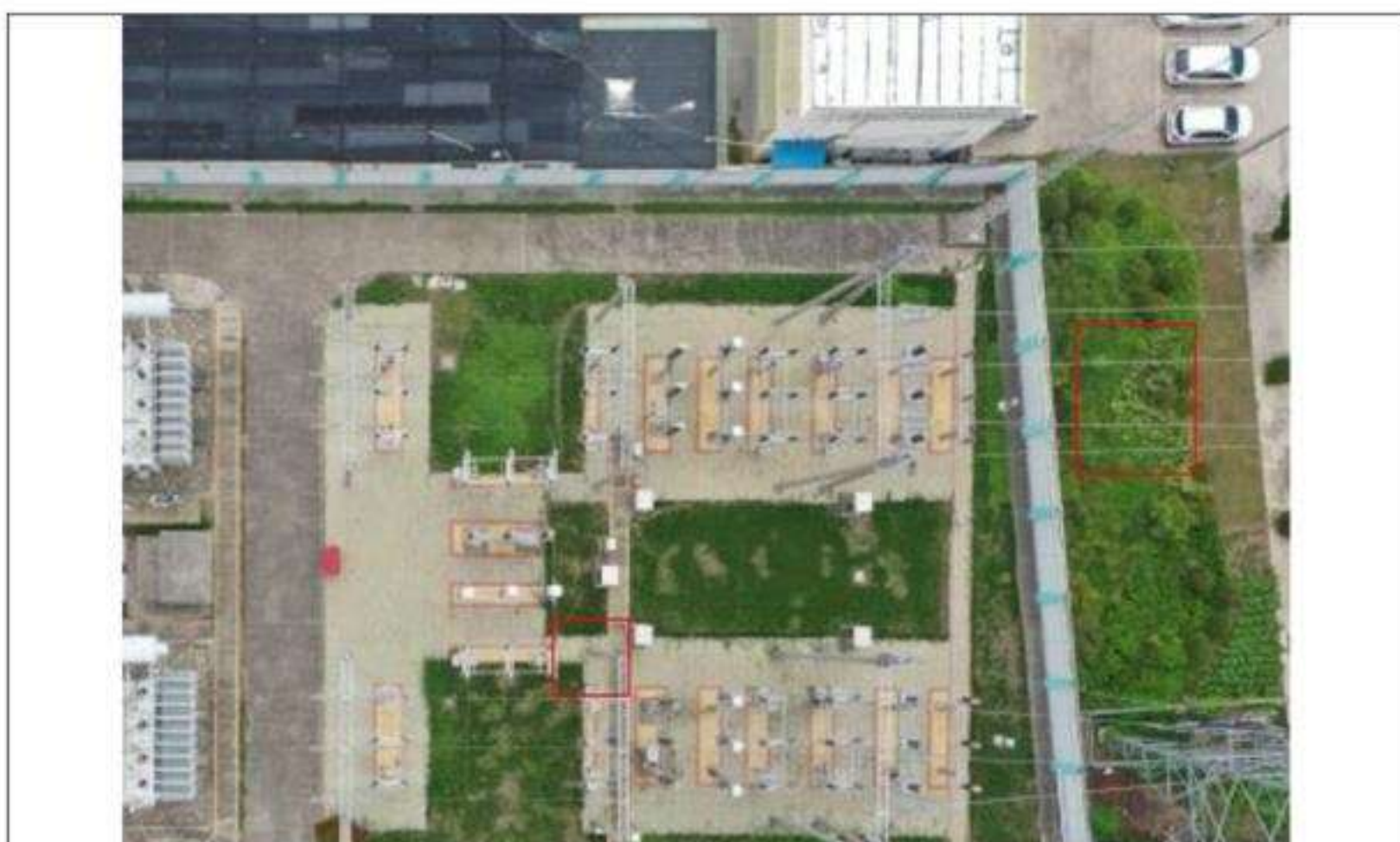
徐州鹿湾 110 千伏变电站改造工程塔基施工前影像
