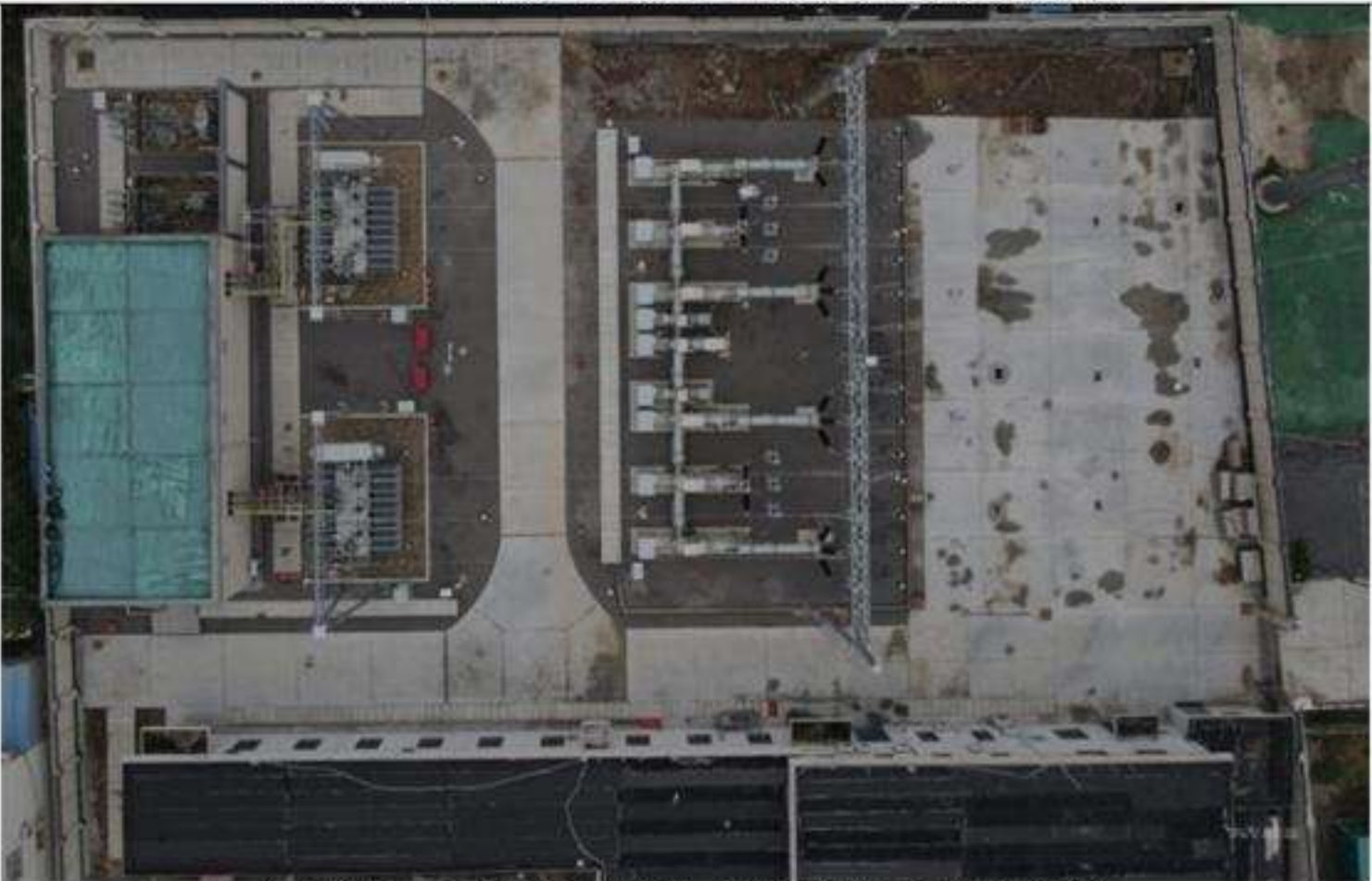
徐州鹿湾 110 千伏变电站改造工程鹿湾变电站改造后影像
