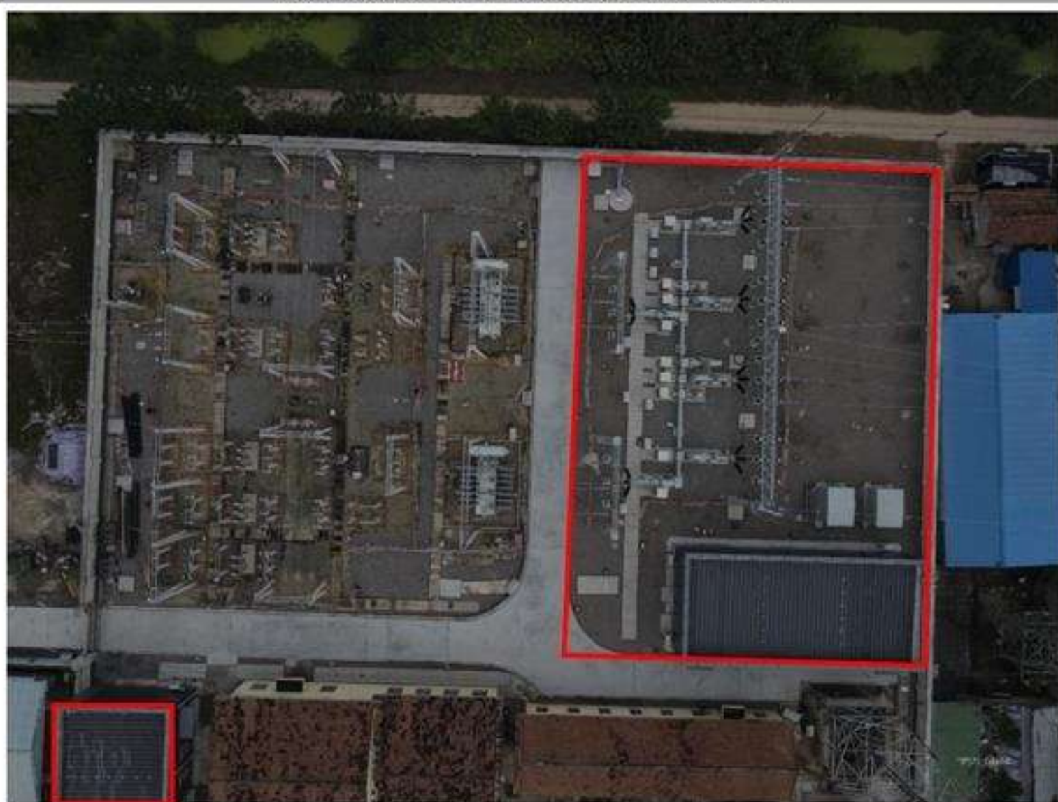
110kV 梁寨变电站建设后影像（2023 年 9 月）
