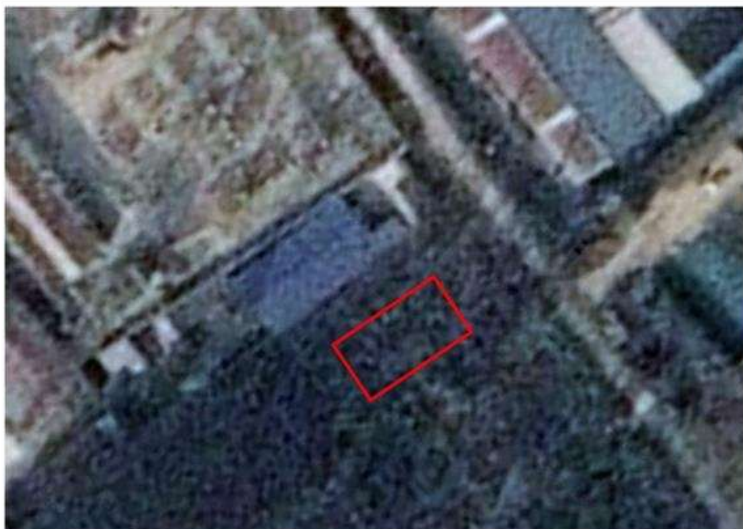
塔基区建设前影像（2022 年 5 月）
