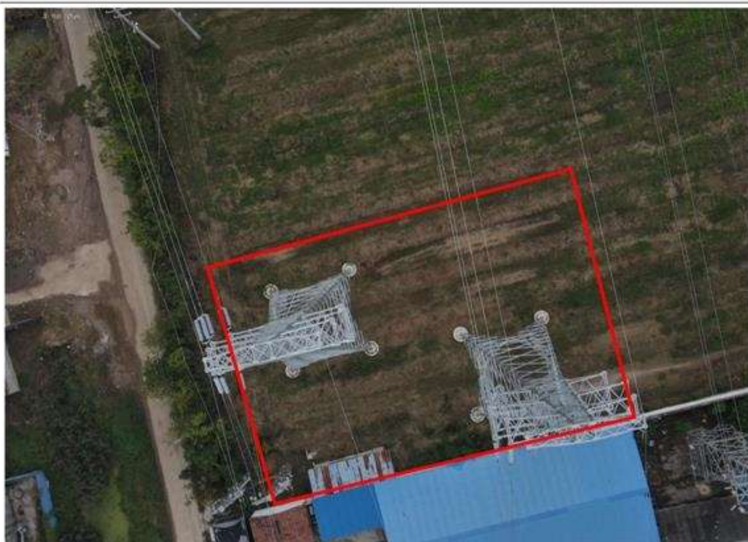
塔基区建设后影像（2023 年 9 月）
