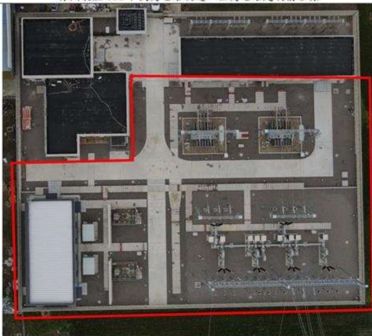
徐州孔庄 110 千伏变电站改造工程变电站改造后影像
