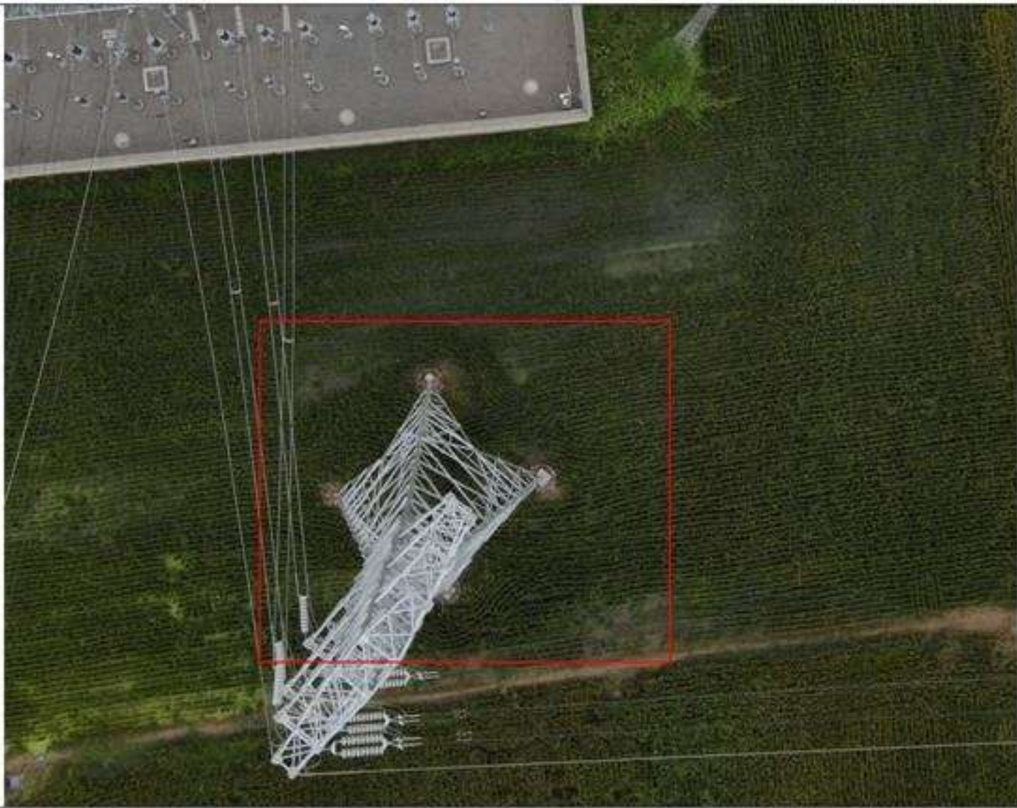
徐州孔庄 110 千伏变电站改造工程塔基施工后影像
