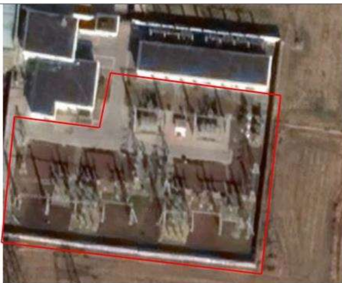
徐州孔庄 110 千伏变电站改造工程变电站建设前影像
