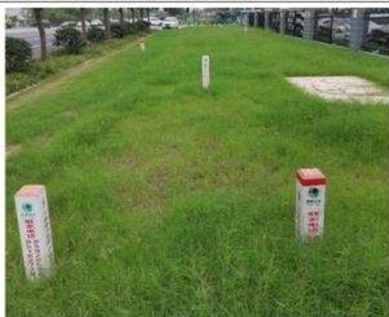
措施名称：电缆施工区植被恢复
