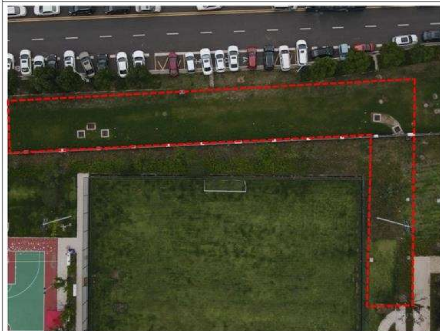
电缆施工区建设后影像（2023 年 9 月）
