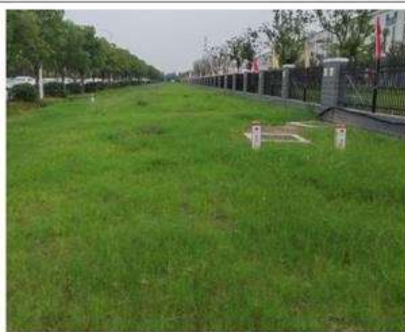
措施名称：电缆施工区植被恢复
