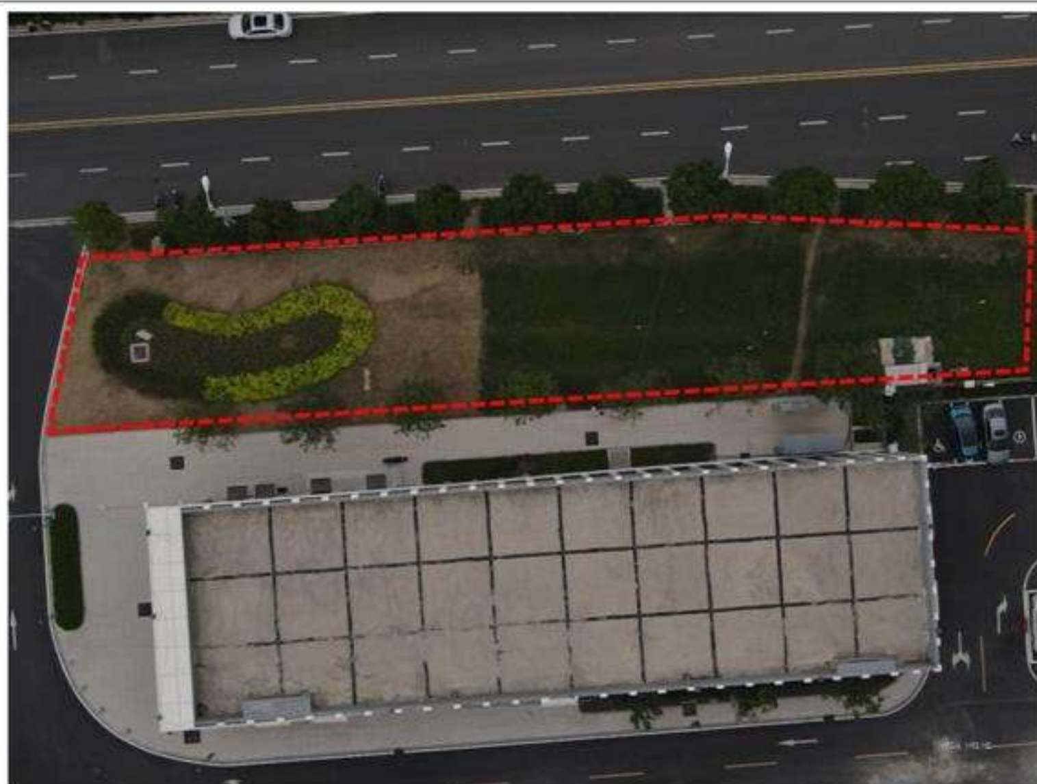
电缆施工区建设后影像（2023 年 9 月）
