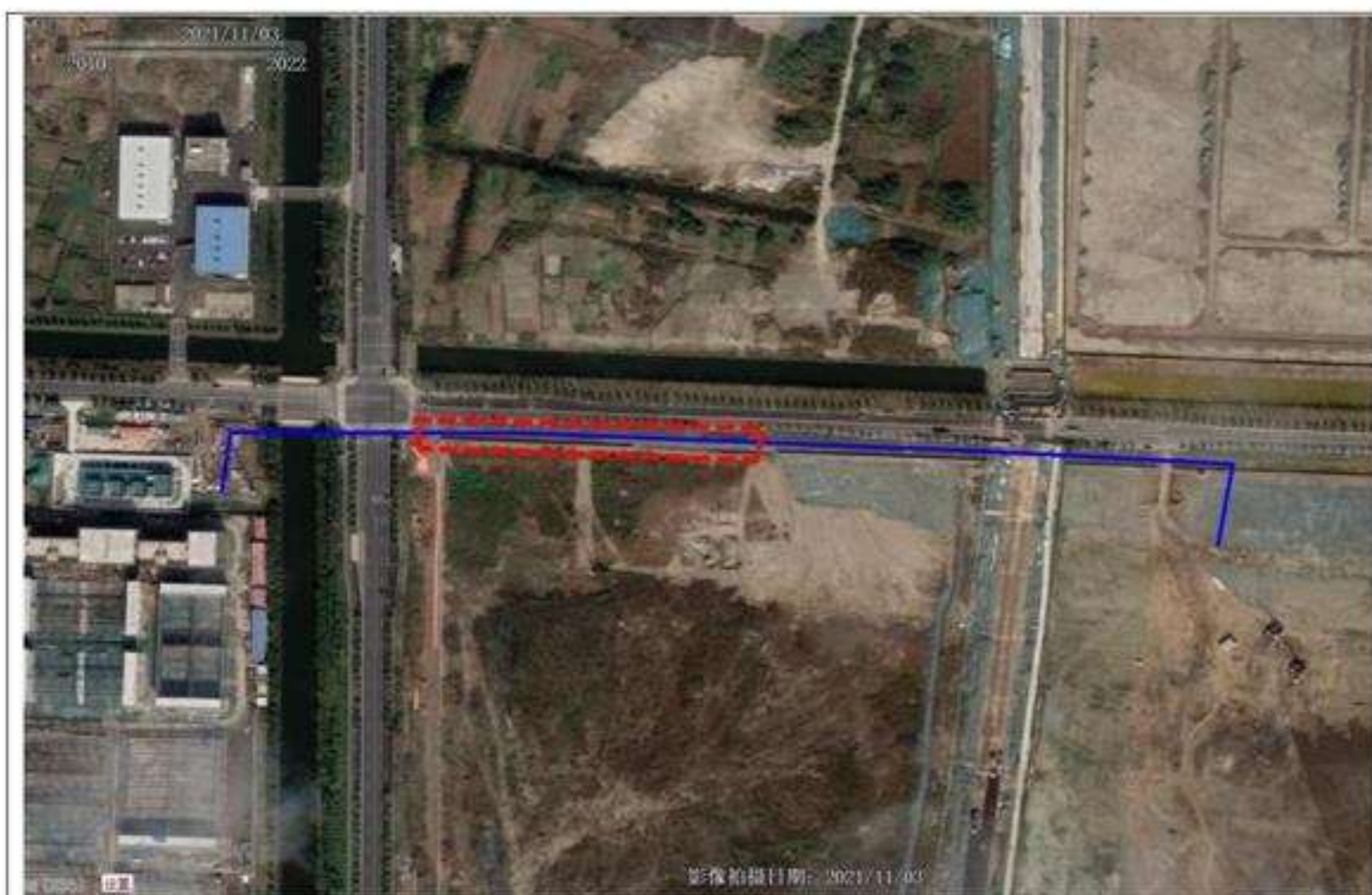
电缆施工区建设前影像（2021 年 11 月）
