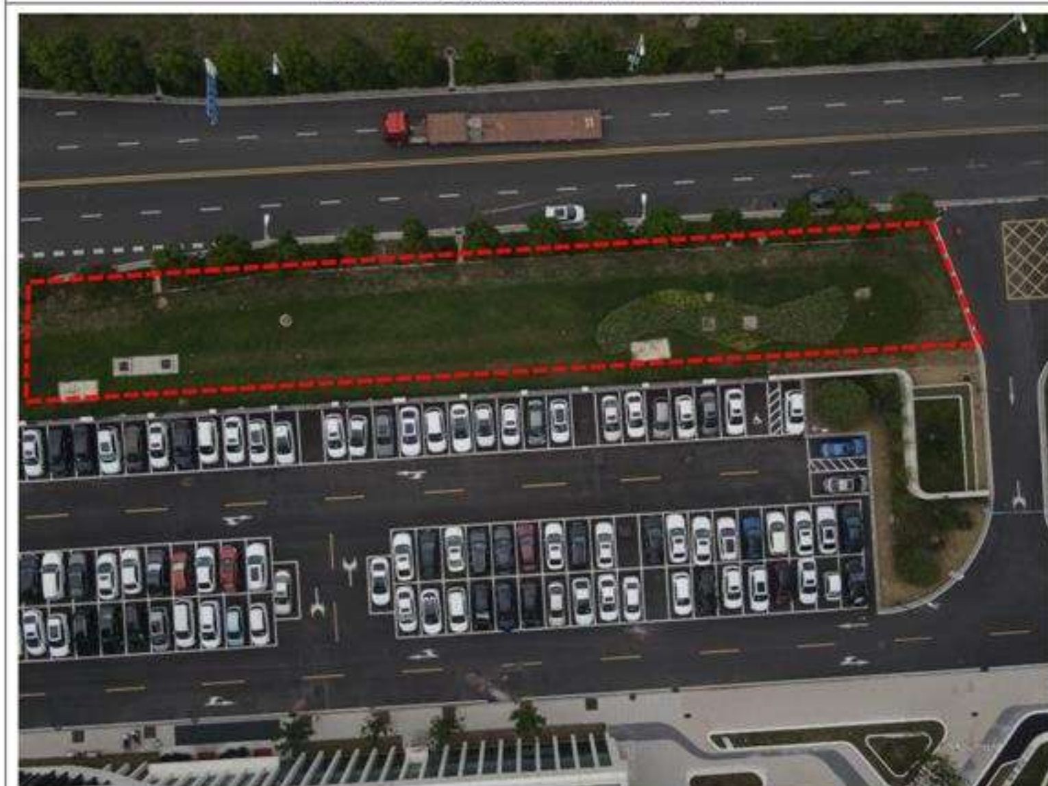
电缆施工区建设后影像（2023 年 9 月）
