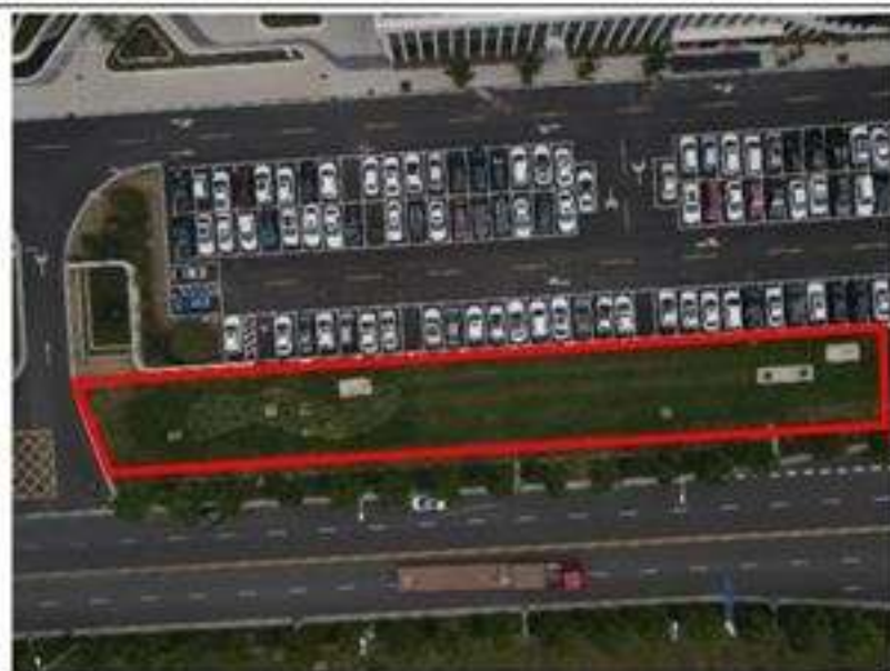
措施名称：电缆施工区植被恢复
