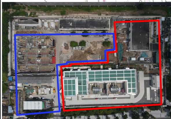
变电站改造区砾石压盖、变电站拆除区土地平整
