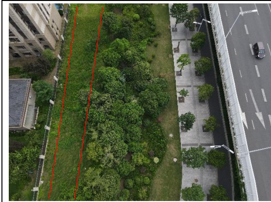
电缆施工区铺植草皮（2023 年 8 月）
