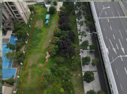
电缆施工区铺植草皮
