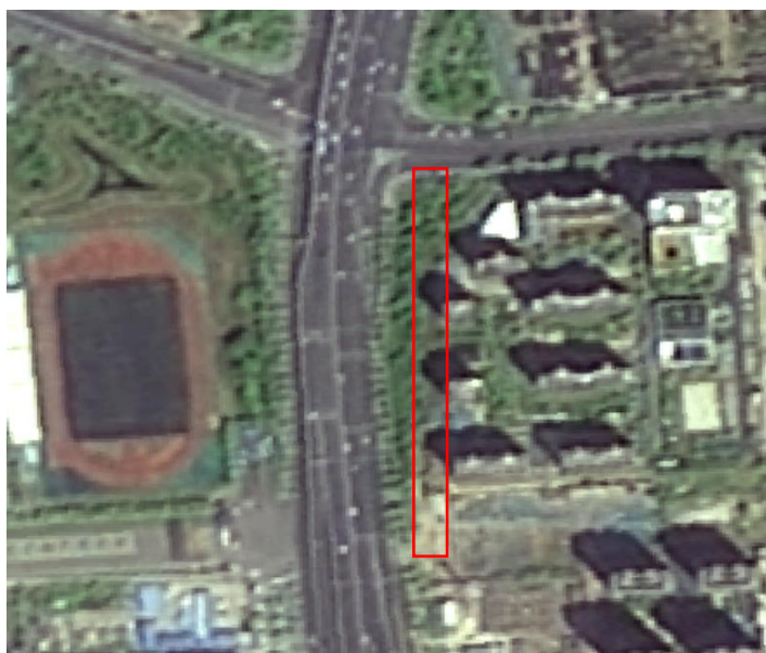
项目施工过程中 2023.05
