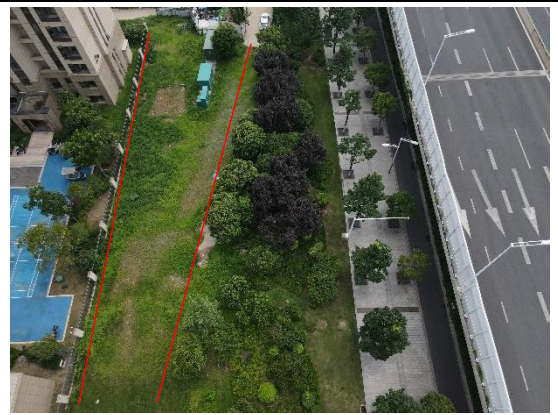
电缆施工区铺植草皮（2023 年 8 月）
