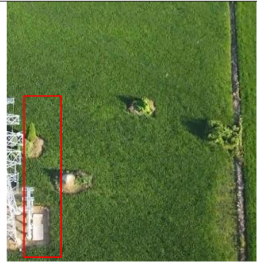
电缆施工区现状（2023.09）
