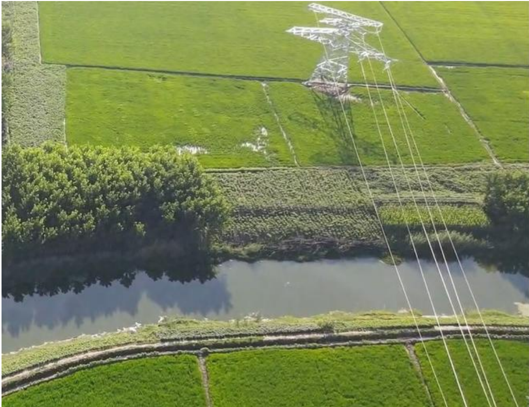
图 1-1 跨越西渭河现场照片
