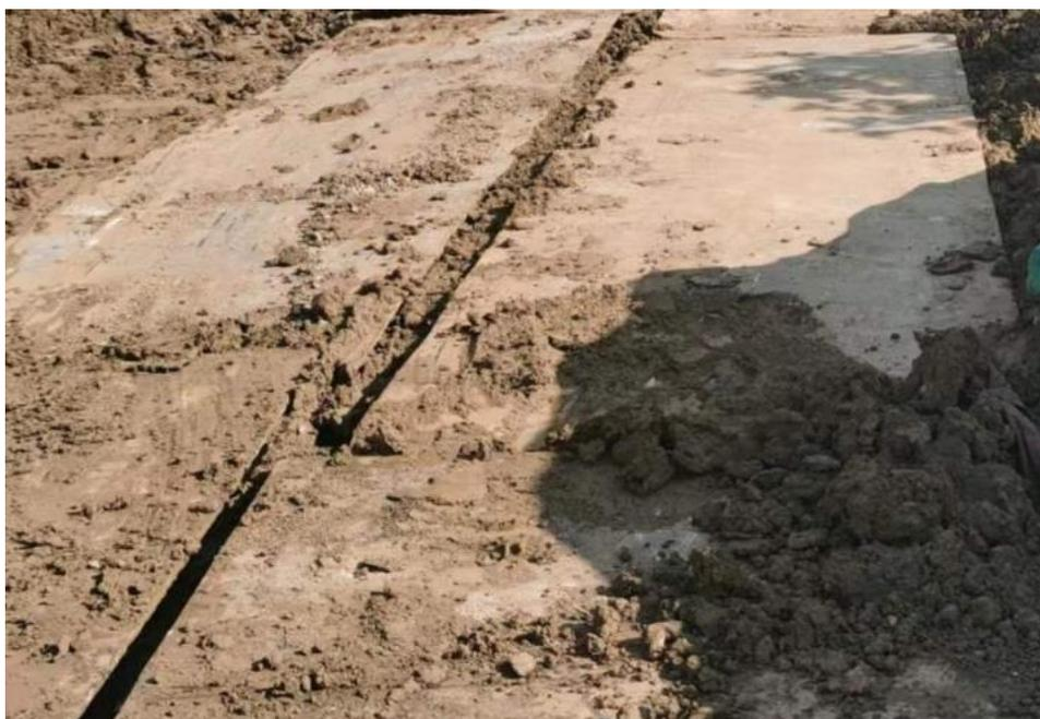
图 4.3.3 跨越场施工区铺设钢板
